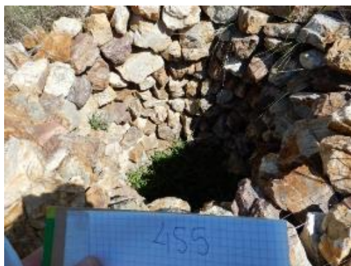
Рисунок 1167 - Объект 455. Колодец без воды, выложенный из камней 1,5×2 м (диаметр/глубина) (Географические координаты: широта 50°0'16,557", долгота 78°6'28,021")
