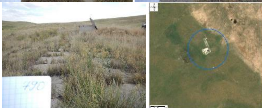
Рисунок 1569 - Объект 790. Скважина, завалена бетонными плитами (Географические координаты: широта 49°45'46,65", долгота 77°53'26,31")
