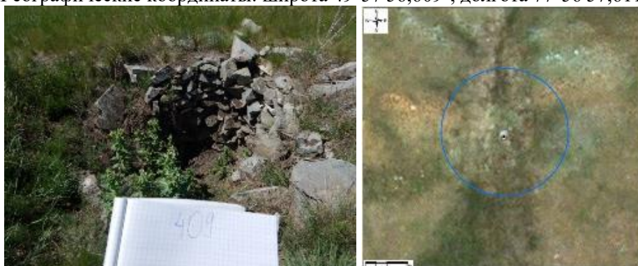
Рисунок 1116 - Объект 409. Колодец без воды, выложенный из камней 1,5×2 м (диаметр/глубина) (Географические координаты: широта 49°58'34,296", долгота 77°57'42,391")
