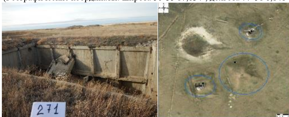
Рисунок 598 - Объект 271 ж/б инженерное сооружение, предположительно служившие бункером, обвалован землей, сверху разрешен, есть вход (Географические координаты: широта 50°35'22,457", долгота 77°51'1,97")
