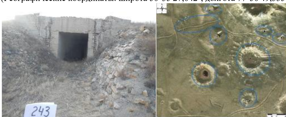
Рисунок 565 - Объект 243 Ж/б подземное сооружение (Географические координаты: широта 50°35'28,858", долгота 77°50'48,585")
