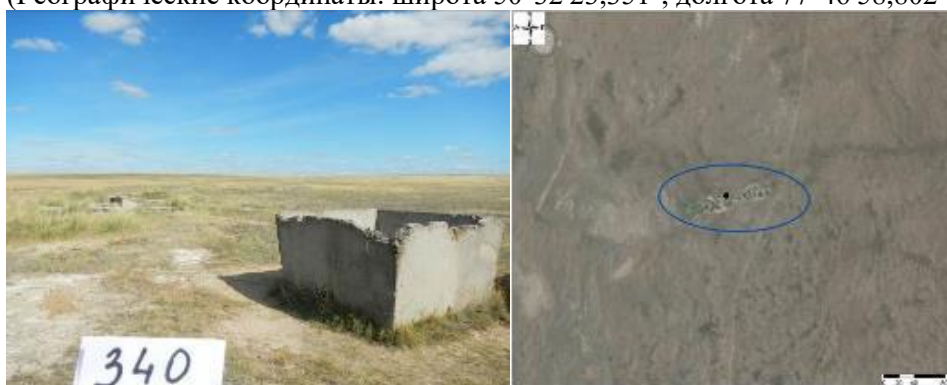
Рисунок 685 - Объект 340 2 колодца с водой, бетонные емкости, ямы диаметром 6м, глубиной 1,5м, водопой (Географические координаты: широта 50^{\circ}47'15,381'' , долгота 77^{\circ}58'37,384'' )
