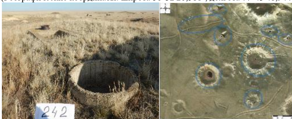
Рисунок 564 - Объект 242. Бункер, обвалованный землей, высота 15-20 м, толщина ж/б стен 50 см, есть небольшой заезд, вход в бункер сверху через 3 люка с металлическими лестницами, вокруг бункера заросшие люки, ж/б вкопанные конструкции (Географические координаты: широта 50°35'27,042", долгота 77°50'49,335")
