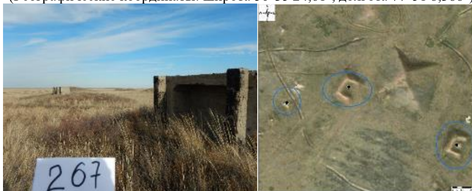
Рисунок 594 - Объект 267 4 Ж/б конструкции (Географические координаты: широта 50°35'24,154", долгота 77°51'5,076")
