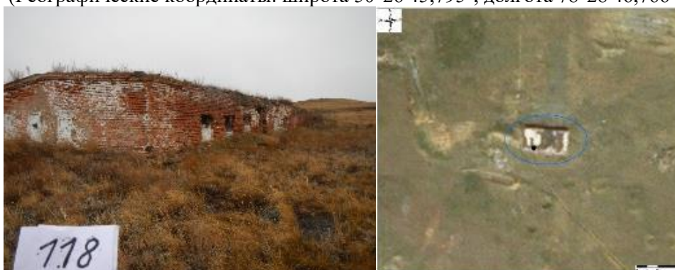
Рисунок 311 - Объект 118. Кирпичное 1-этажное строение (Географические координаты: широта 50°26'45,488", долгота 77°57'50,621")
