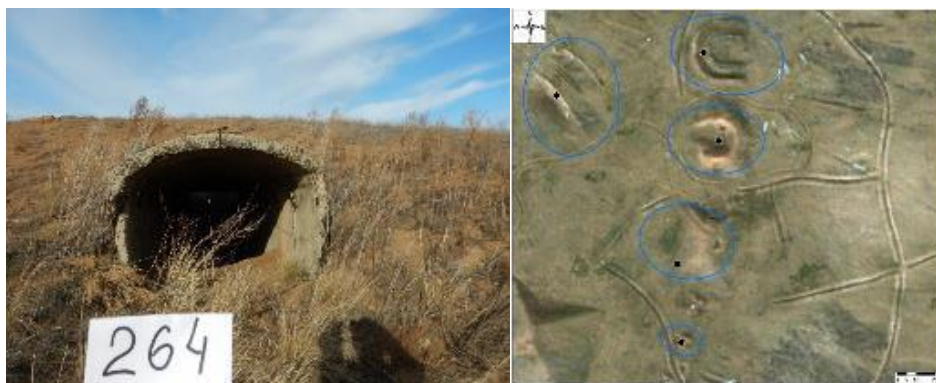
Рисунок 591 - Объект 264 Окоп глубиной 2 м, ж/б проход, бетонная площадка (Географические координаты: широта 50°35'28,081", долгота 77°51'16,705")
