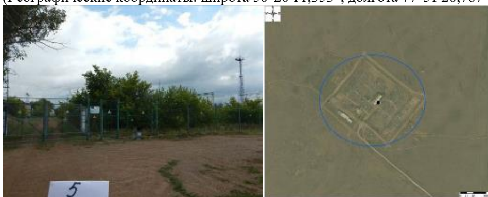
Рисунок 19 - Объект 5. 51 электростанция (Географические координаты: широта 50°36'18,577", долгота 78°30'24,364")
