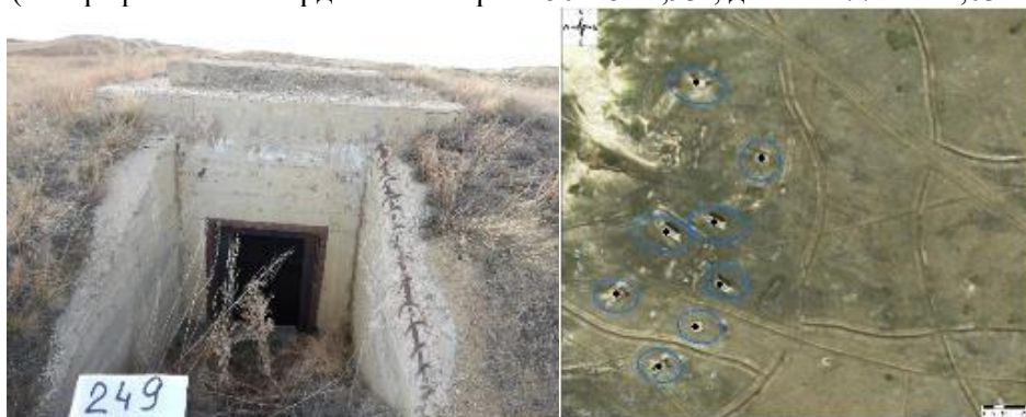
Рисунок 573 - Объект 249 Ж/б сооружение, предположительно бункер, обвалован землей (Географические координаты: широта 50°35'29,977", долгота 77°50'58,521")
