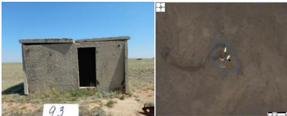
Рисунок 252 - Объект 94 ж/б строение, внутри скважина с двумя обсадными трубами диаметром 20 и 40 см без воды (Географические координаты: широта 50°30'15,569", долгота 78°13'14,655")
