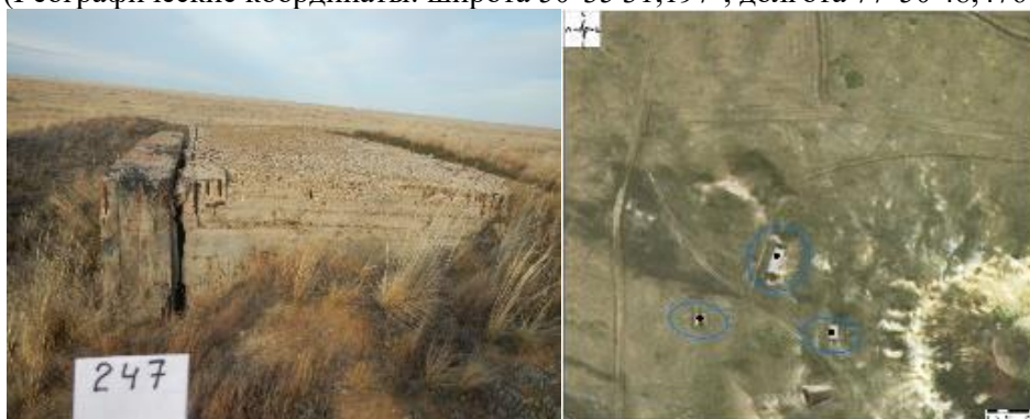
Рисунок 569 - Объект 247 Ж/б подземное сооружение (Географические координаты: широта 50°35'29,974", долгота 77°50'49,734")
