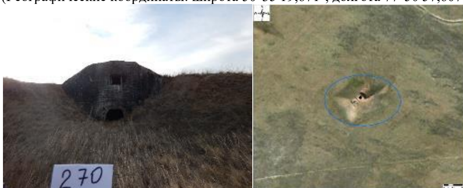
Рисунок 597 - Объект 270 полуовальное ж/б инженерное сооружение, обваловано землей, имеется вход (Географические координаты: широта 50°35'17,634", долгота 77°51'6,848")
