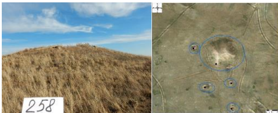
Рисунок 583 - Объект 258 Ж/б инженерное сооружение, предположительно служившее бункером, обваловано землей, вход сверху (Географические координаты: широта 50°35'32,009", долгота 77°51'9,024")
