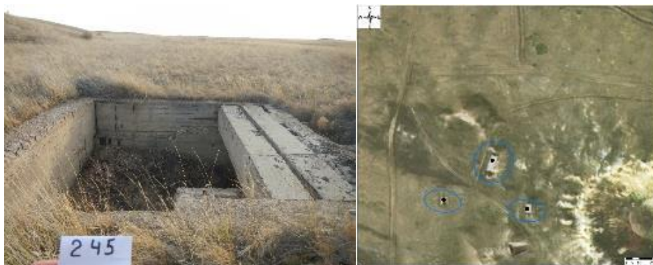
Рисунок 567 - Объект 245 Ж/б подземное сооружение (Географические координаты: широта 50°35'30,284", долгота 77°50'46,551")
