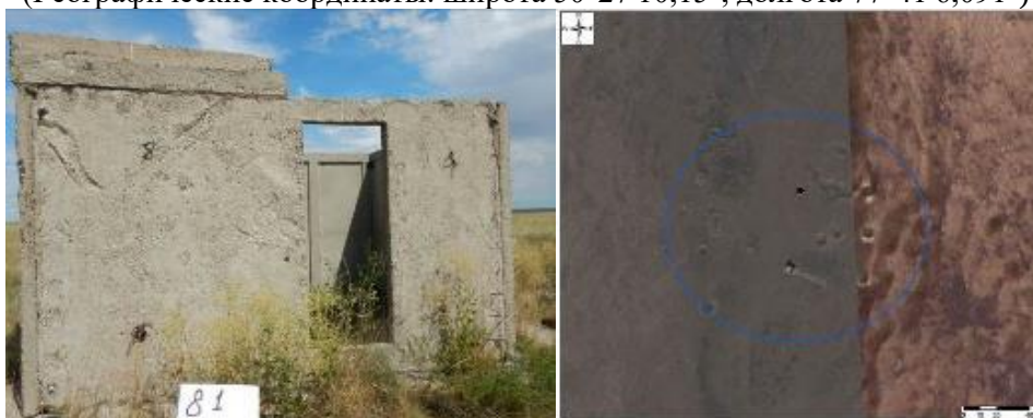
Рисунок 222 - Объект 81. Бетонное сооружение (поилка) (Географические координаты: широта 50°30'56,225", долгота 78°22'27,918")
