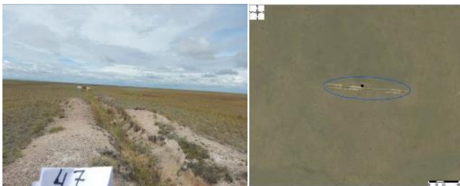
Рисунок 137 - Объект 47. Траншея 150×1×1 м, насыпь 0,5 м (Географические координаты: широта 50°32'44,425", долгота 78°35'16,519")
