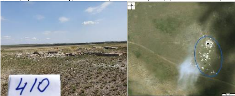
Рисунок 773 - Объект 410 Развалины, бетонные плиты, кирпичи (Географические координаты: широта 50°19'27,332", долгота 77°49'28,385")
