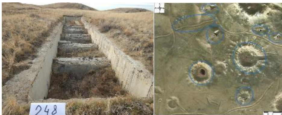
Рисунок 571 - Объект 248 Ж/б подземное сооружение (Географические координаты: широта 50°35'27,253", долгота 77°50'54,56")
