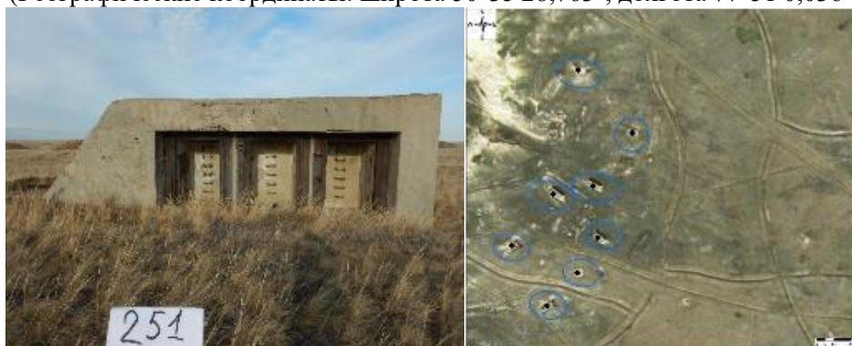
Рисунок 576 - Объект 251 Ж/б сооружение (Географические координаты: широта 50°35'27,793", долгота 77°50'58,816")
