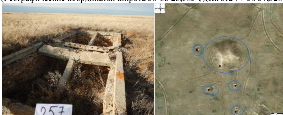
Рисунок 582 - Объект 257 Ж/б сооружение, стены сложены скальной породой, глубиной 1,5 м, 20×5 м (Географические координаты: широта 50°35'32,97", долгота 77°51'7,048")
