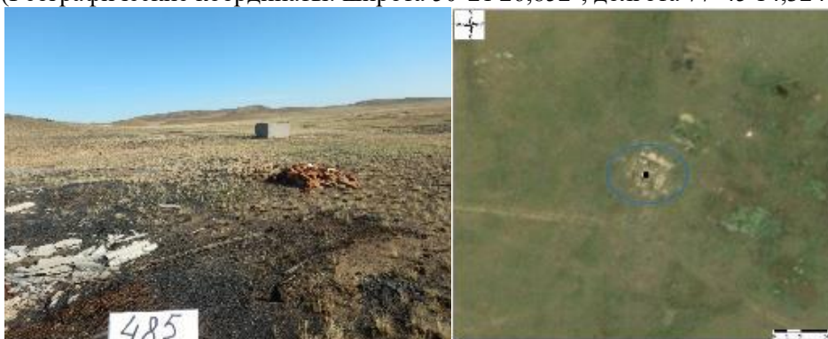
Рисунок 865 - Объект 485 Развалины, строительный мусор, бетонные емкости, сетка рабица, шифер (Географические координаты: широта 50°19'43,169", долгота 77°45'9,698")
