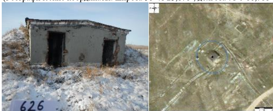
Рисунок 1065 - Объект 626 Железобетонное сооружение (Географические координаты: широта 50^{\circ}30'5,902'' , долгота 77^{\circ}54'49,429'' )
