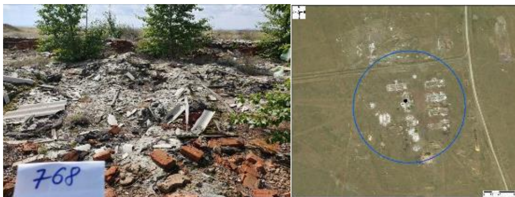
Рисунок 1227 - Объект 768 Развалины наземного структурного строения, фундамент, бетонные блоки, стекловата 100х20м (Географические координаты: широта 50°26'56,543", долгота 77°57'47,229")
