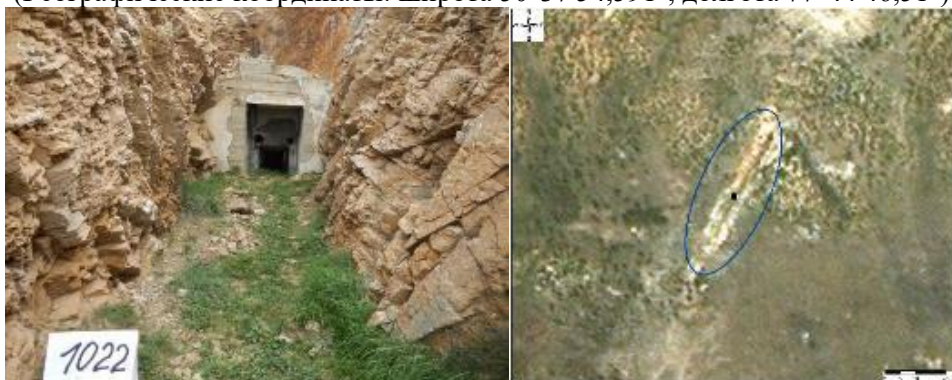
Рисунок 1358 - Объект 1022 горизонтальная горная выработка, подземное сооружение (Географические координаты: широта 50°39'22,798", долгота 77°44'21,275")
