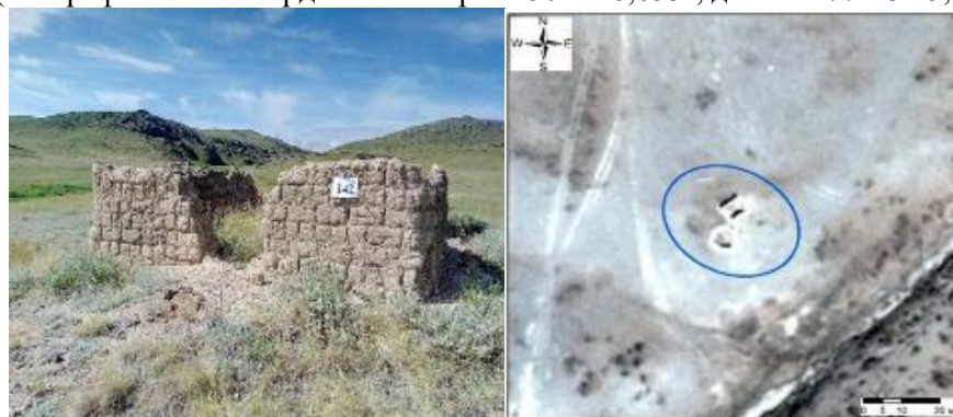
Рисунок 190 - Объект 142. Разрушенное строение из самана (Географические координаты: широта 50°1'29,49", долгота 77°26'55,716")
