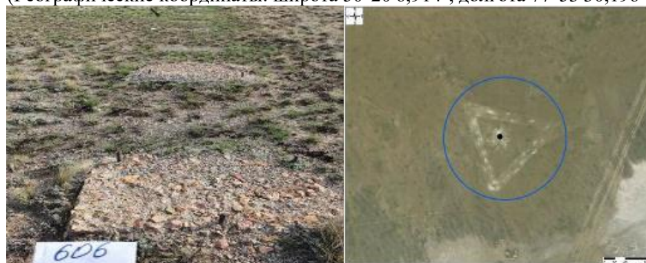
Рисунок 1042 - Объект 606 7 бетонных площадок 0,5x1м, расстояние между площадками 0,5м, по углам арматура (Географические координаты: широта 50°22'57,743", долгота 77°54'46,482")
