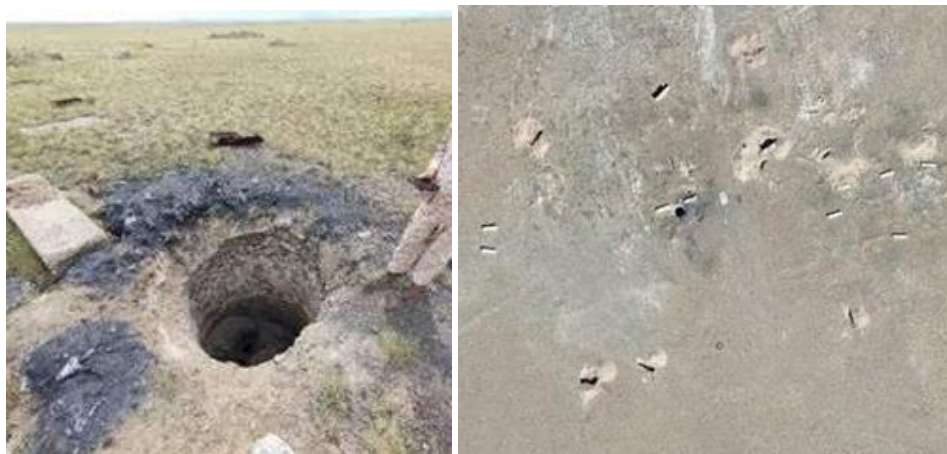
Рисунок 1388 - Объект скважина 3001-Б, диаметр 1,7 м, глубина 500 м, опалубка бетонная, завалена мусором до отметки 6-7 м, ниже грунтовые воды, вокруг усиленные борта, бетонные упоры (Географические координаты: широта 50°07'42,2", долгота 77°43'45,4")
