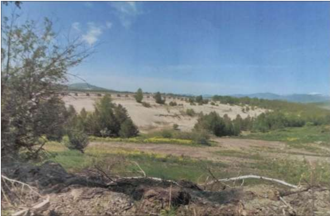
Рисунок 6 Фотоиллюстрация низового откоса плотины Чашинского хвостохранилища со стороны Ловчего канала
