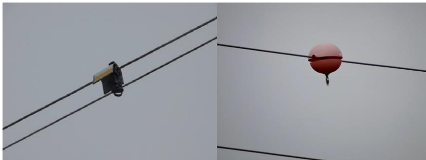
Рисунок 32 - Пример маркирующих устройств, предотвращающих столкновение птиц с проводами
