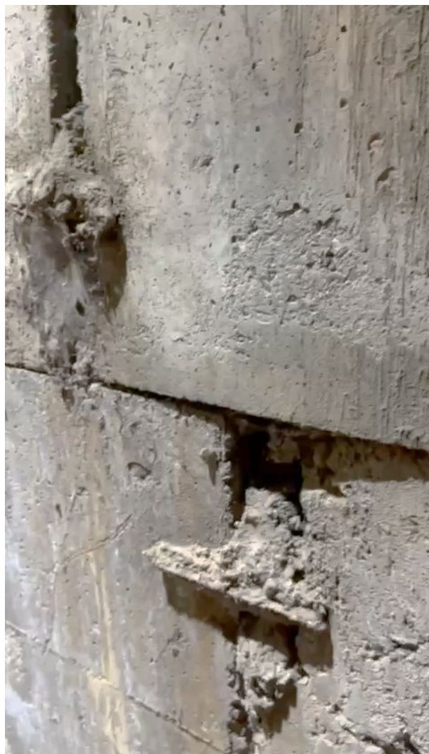
Рис.8.8. Вид на внутреннюю поверхность башни управления. Крепление плитами.
