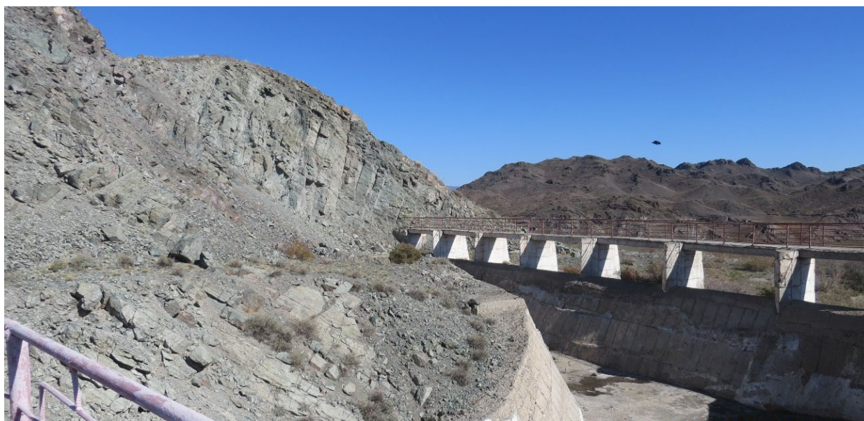
Рис.8.14. Вид на ковшовую часть водосброса.
