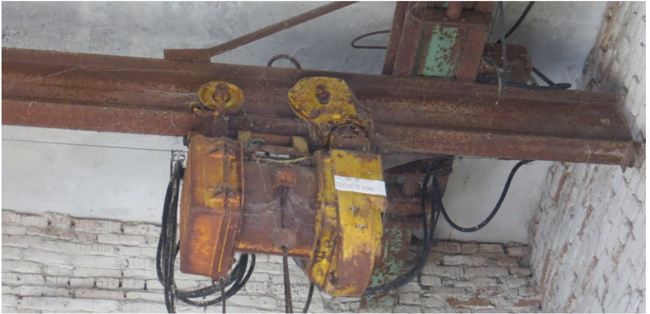
Рис.8.10. Подъемный механизм. Замена на новый механизм с электрическим приводом.
