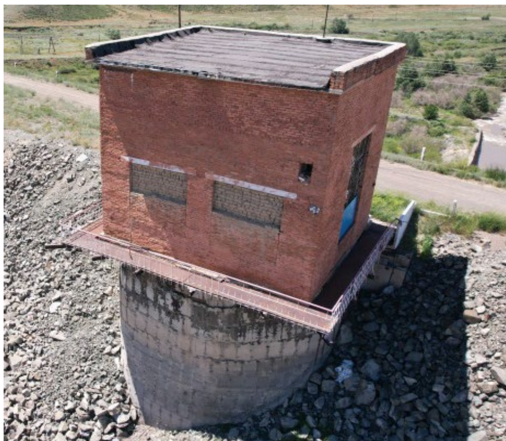
Рис.8.5. Вид на надбашенное строение башни управления водовыпуска.
