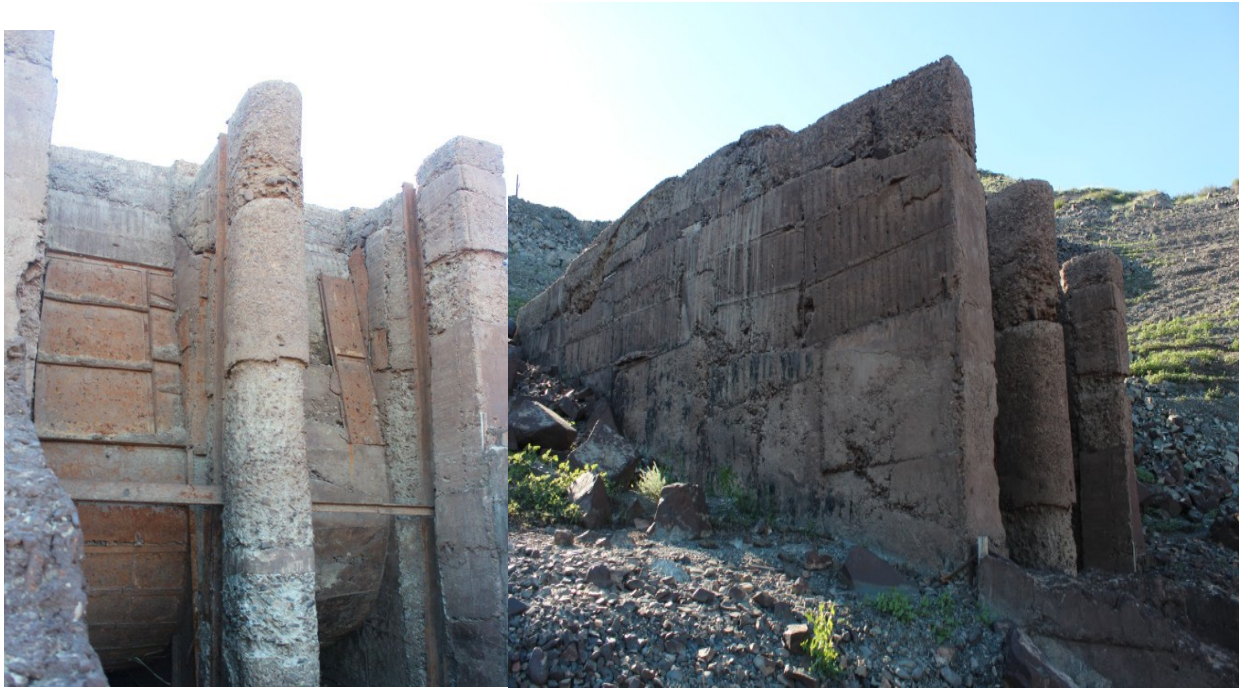
Рис.8.2. Входные отверстия оголовка.
