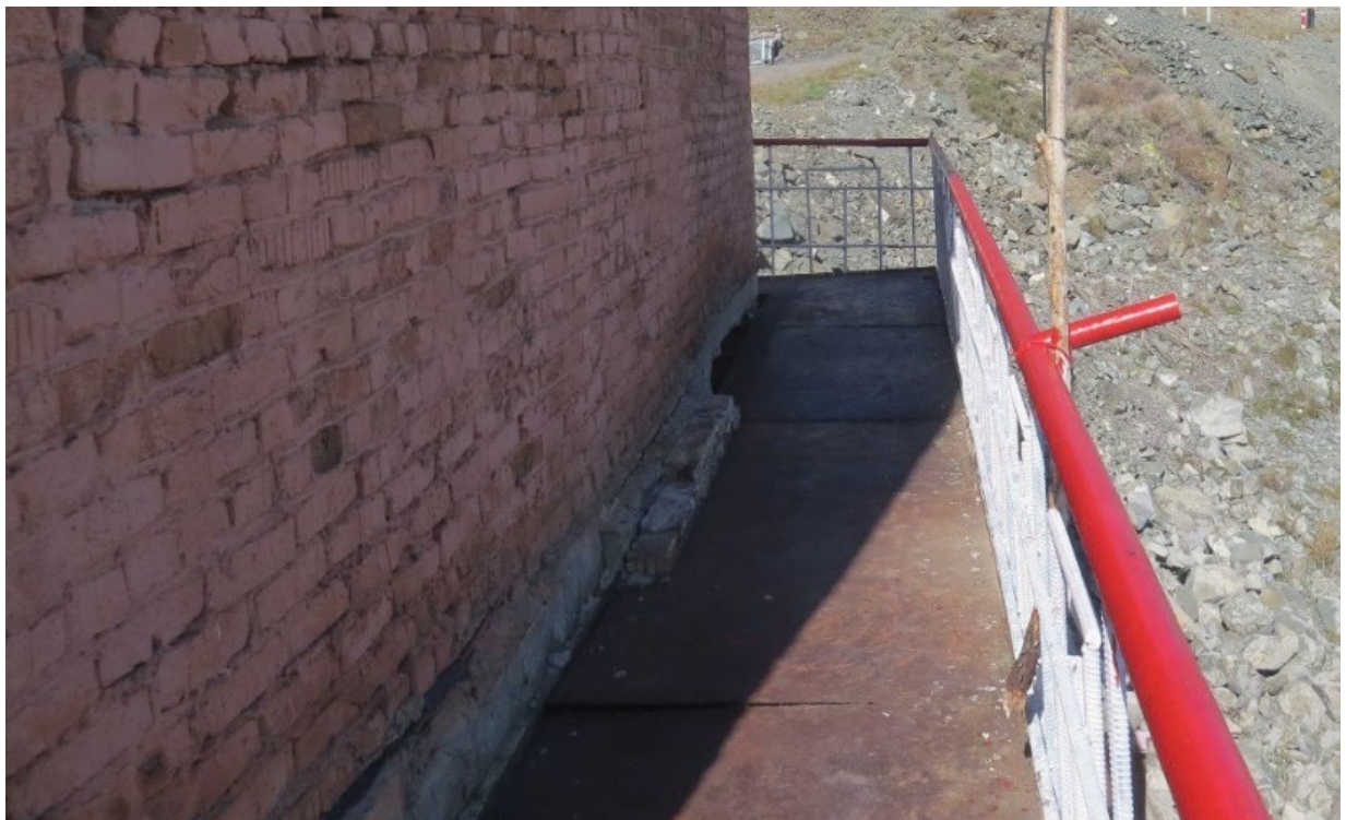
Рис.8.11. Наружная поверхность стен и служебный металлический мостик.
