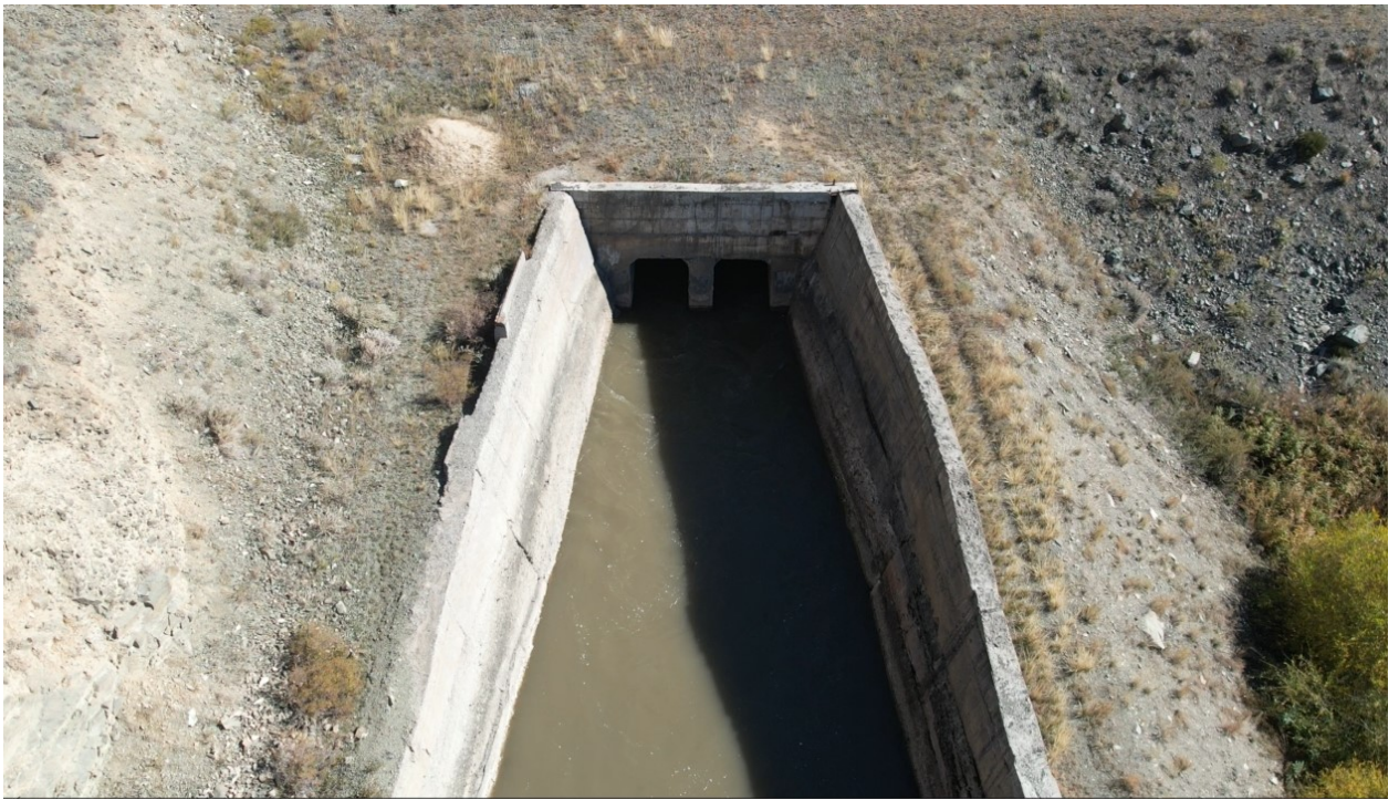
Рис.8.3 Вид на выходной оголовок.
