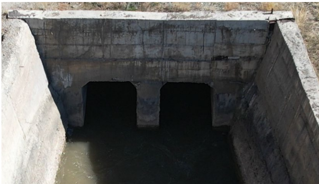
Рис.8.4. Вид на выходные отверстия.
