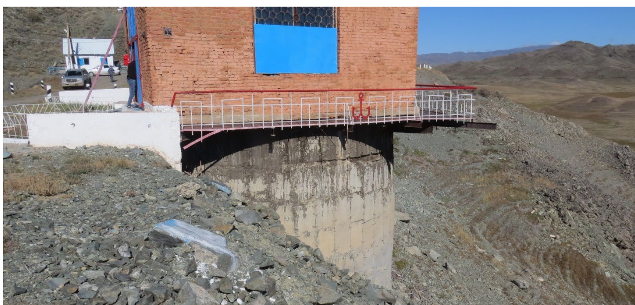
Рис.8.6. Вид на башню управления водовыпуска.
