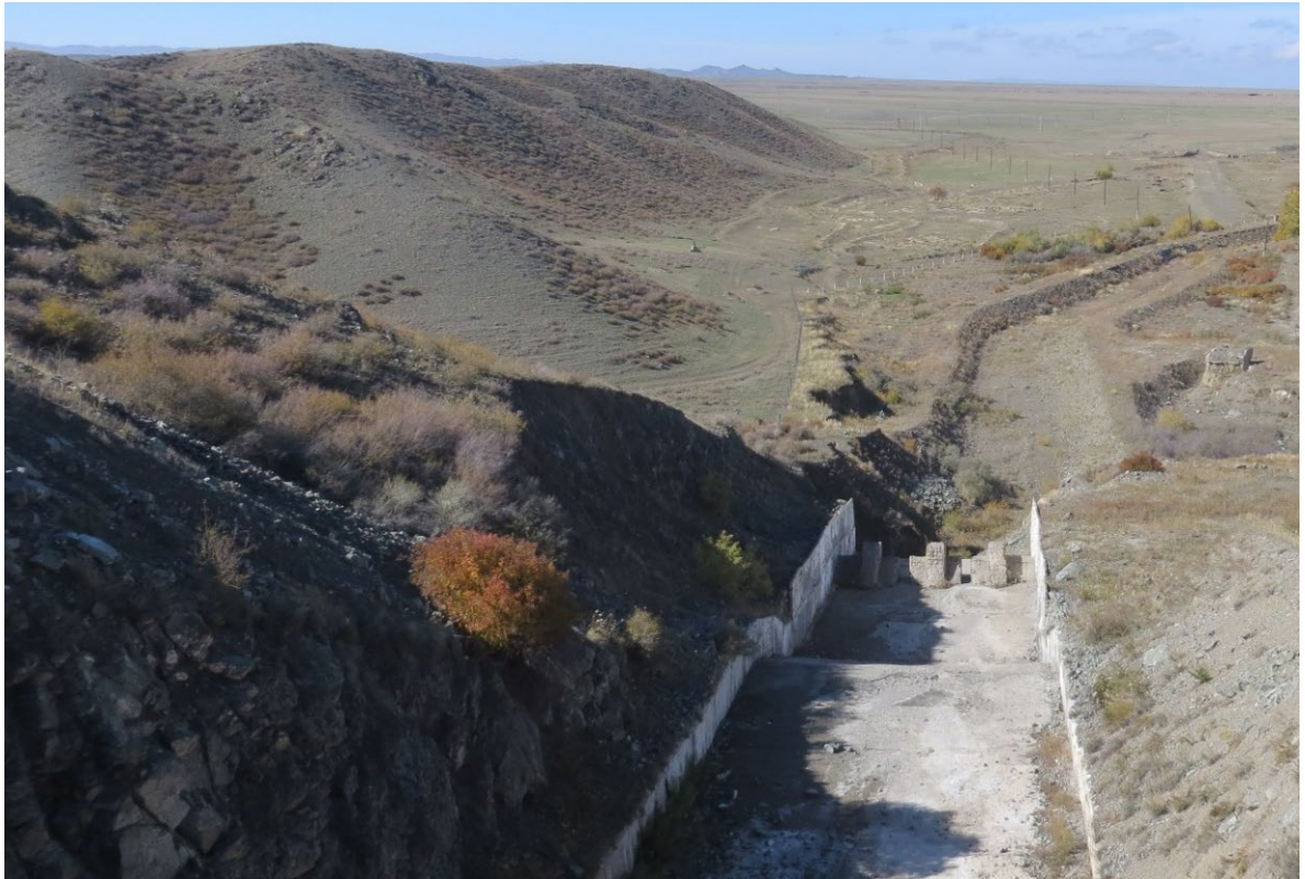
Рис.8.15. Вид на быстроточную часть водосброса.
