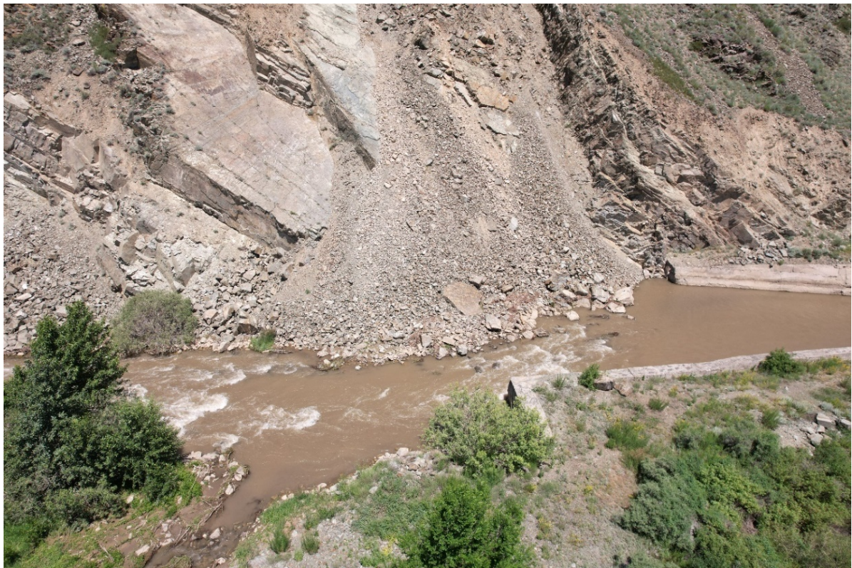
Рис.8.16. Обрушение склона в нижнем бьефе плотины. Выходной оголовок водосбросного сооружения.
