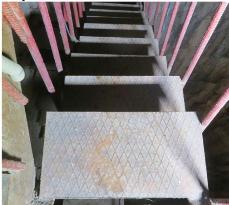
Вид на эксплуатационную лестницу.
