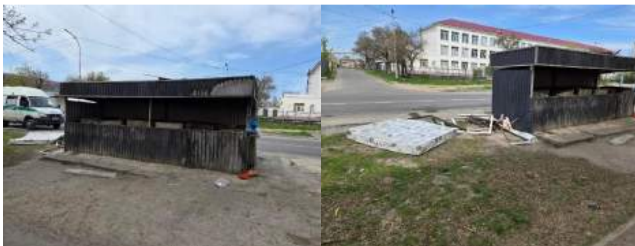
Рисунок 15.21– Состояние контейнерной площадки в г. Кентау (площадка 10)
