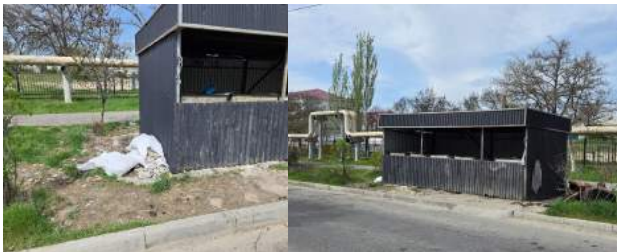
Рисунок 15.20– Состояние контейнерной площадки в г. Кентау (площадка 9)
