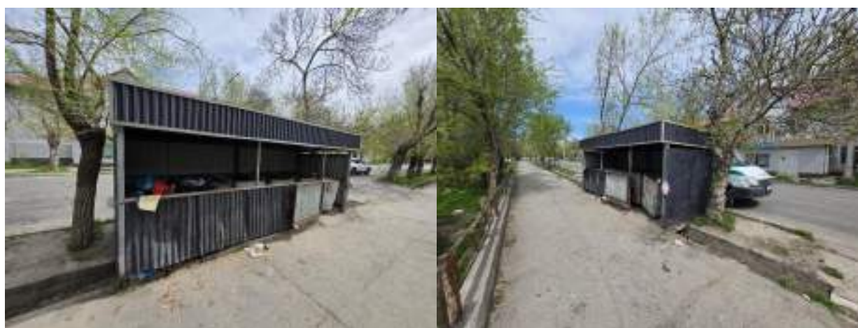
Рисунок 15.18– Состояние контейнерной площадки в г. Кентау (площадка 7)
