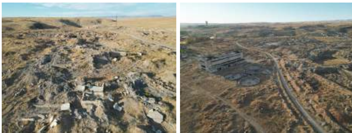
Рисунок 12.2.10 – Деградированная территория на промзоне г. Кентау (разрушенные промышленные и административные здания) (2025г.)
