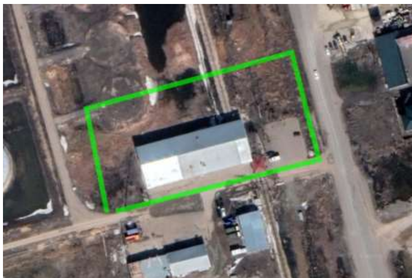
ТП 356 яч. 10 выход ВЛ 10 кВ РП 9, КЛ-27
