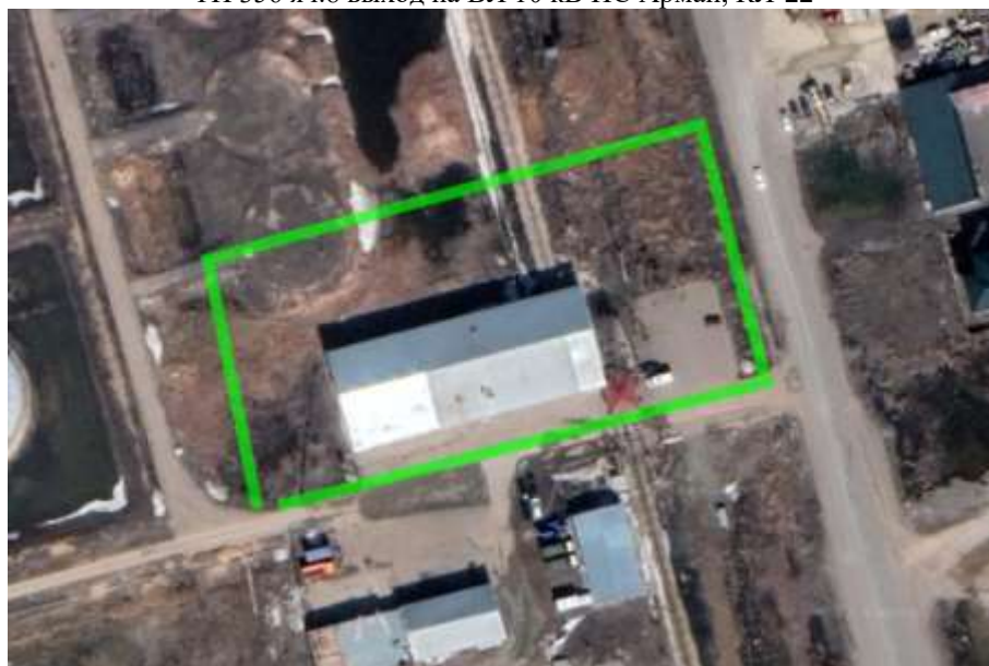
ТП 356 яч. 7 выход на ВЛ 10 кВ ТП 357, КЛ-26
