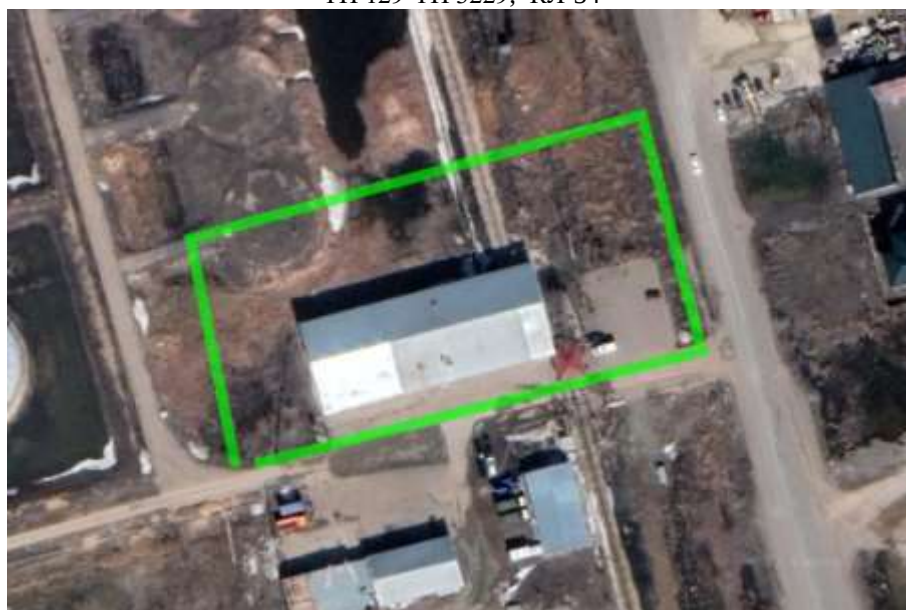
ТП 356 яч.8 выход на ВЛ 10 кВ ПС Арман, КЛ-22
