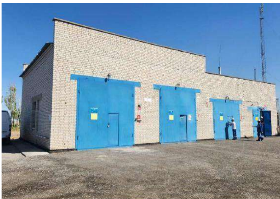
Рисунок 1.1.4 – Общий вид здания котельной
