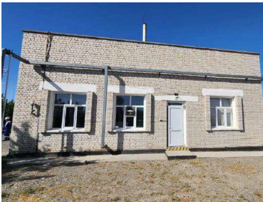
Рисунок 1.1.3 – Общий вид здания котельной
