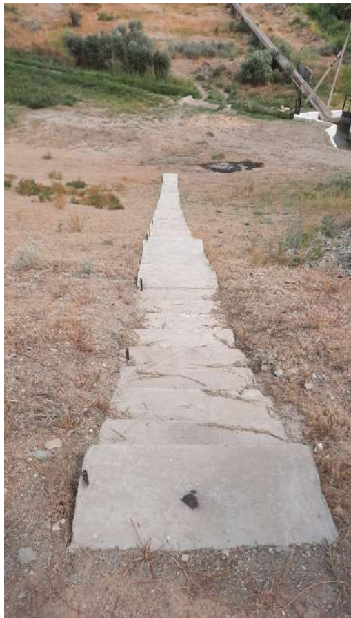
Рис.7.12 Вид на эксплуатационную лестницу в нижнем бьефе плотины.
