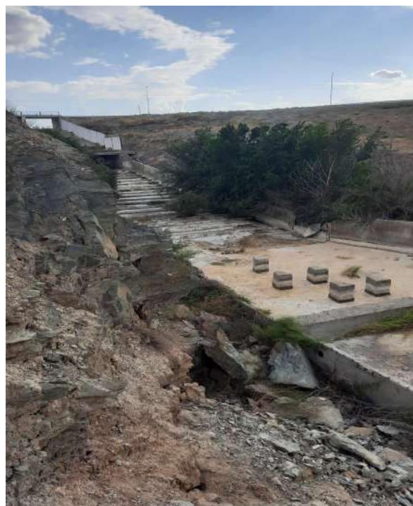
Рис.7.3 и 7.4 Вид на отводящее русла катастрофического сброса, разрушения стенок из ж/б блоков Г-20, дна ступенчатого гасителя и водобоя с шашочными гасителями сооружения
