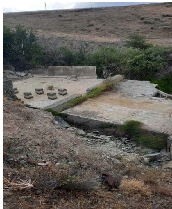
Рис 7.5 и 7.6 дно водобоя с гасителями шашечного типа и сопряженной рисбермы в разрушенном состоянии.
