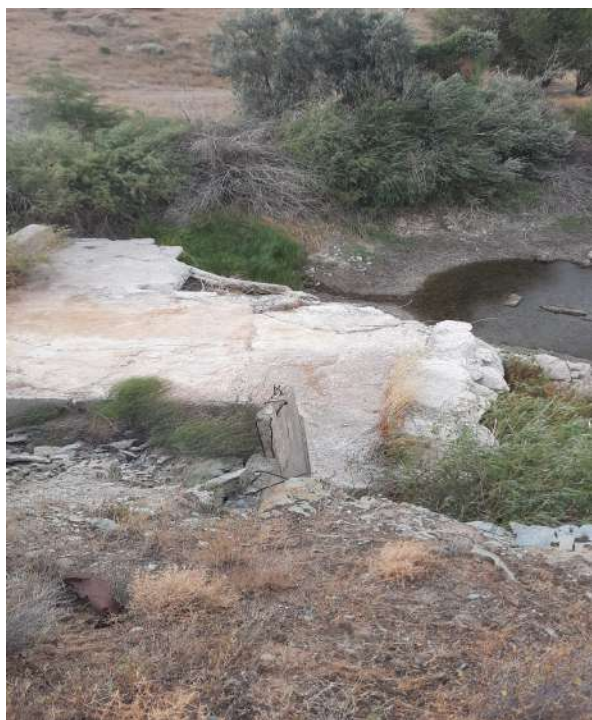
Рис 7.5 и 7.6 дно водобоя с гасителями шашечного типа и сопряженной рисбермы в разрушенном состоянии.
