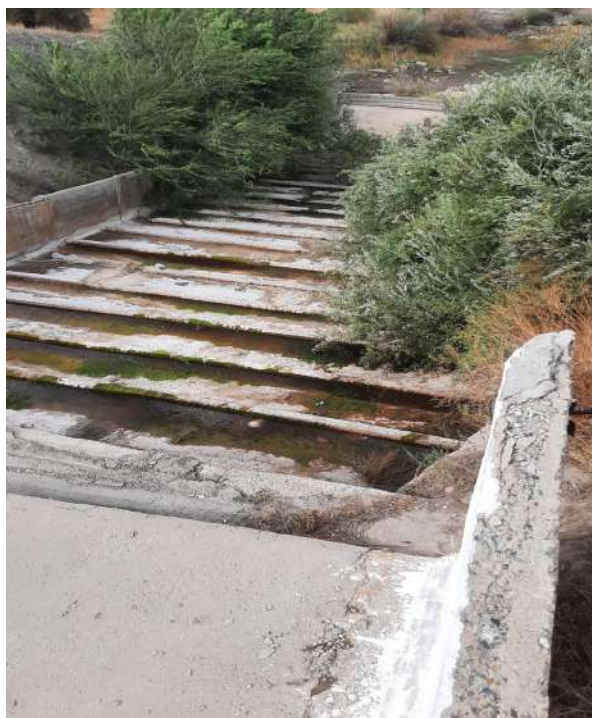
Рис.7.3 и 7.4 Вид на отводящее русла катастрофического сброса, разрушения стенок из ж/б блоков Г-20, дна ступенчатого гасителя и водобоя с шашочными гасителями сооружения
