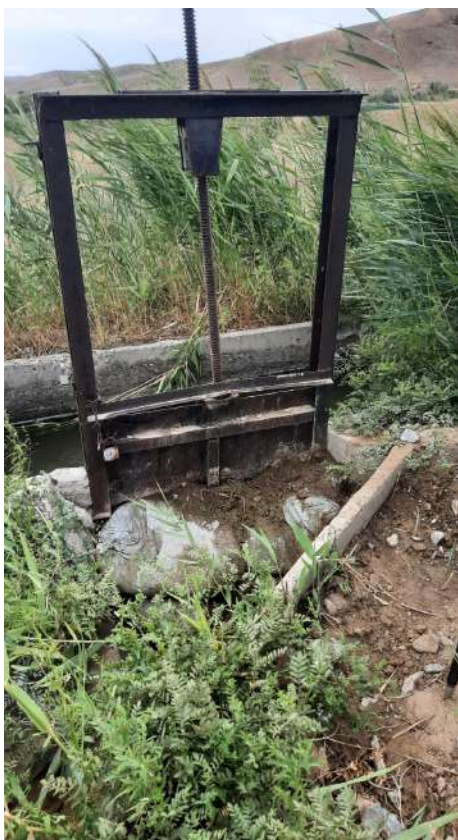
Рис.7.14 Водовыпуски на магистральном канале.
