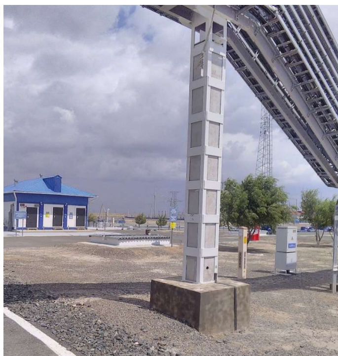
Общий вид опоры кабельной эстакады 56
