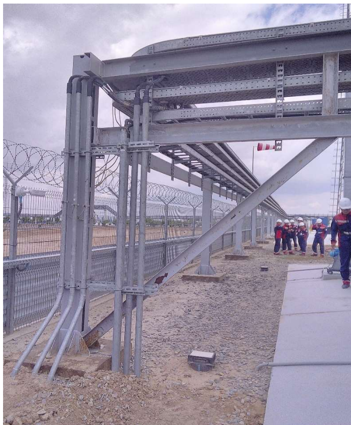
Общий вид опоры кабельной эстакады 108
