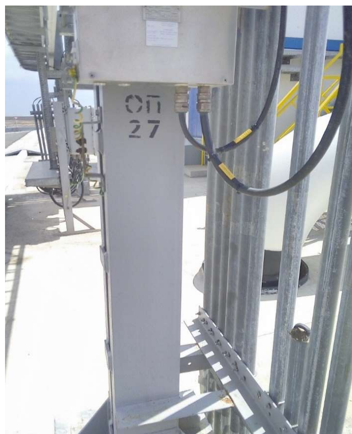
Общий вид опоры кабельной эстакады 27
