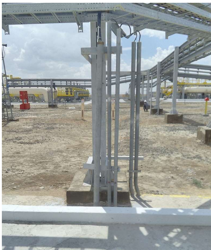
Общий вид опоры кабельной эстакады 30
