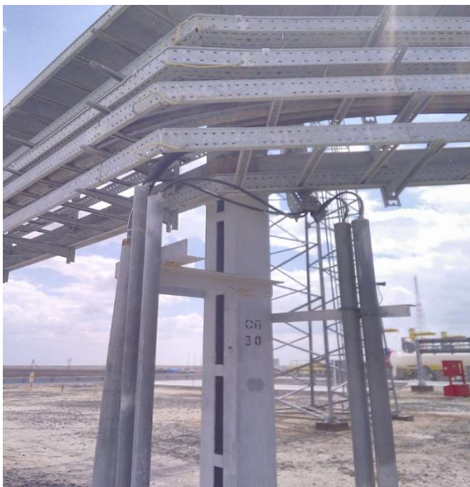
Общий вид опоры кабельной эстакады 30
