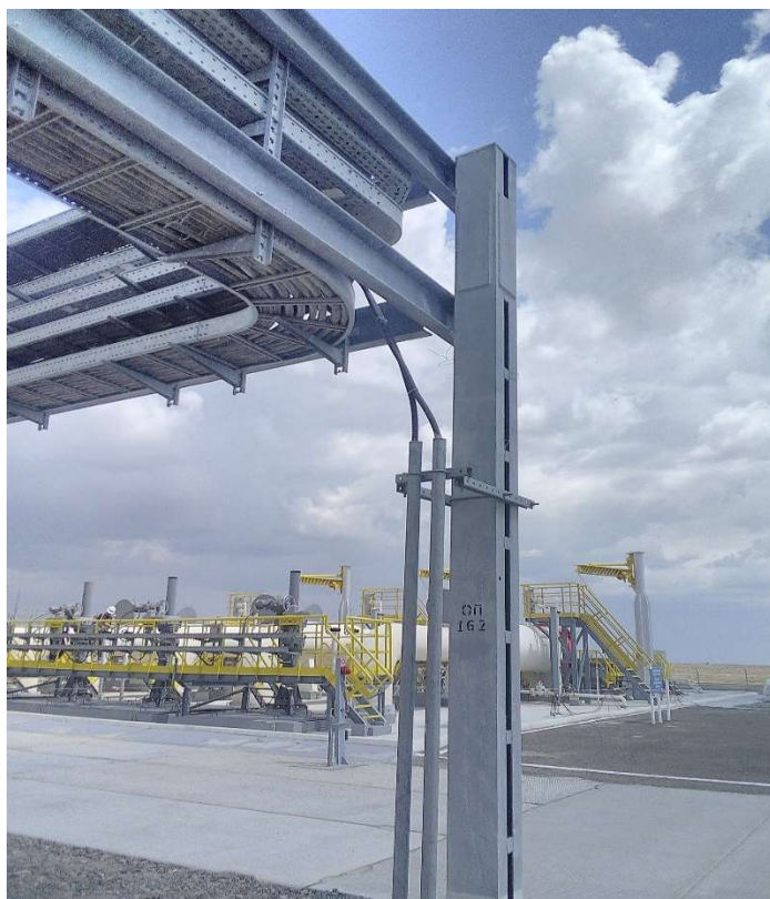
Общий вид опоры кабельной эстакады 162
