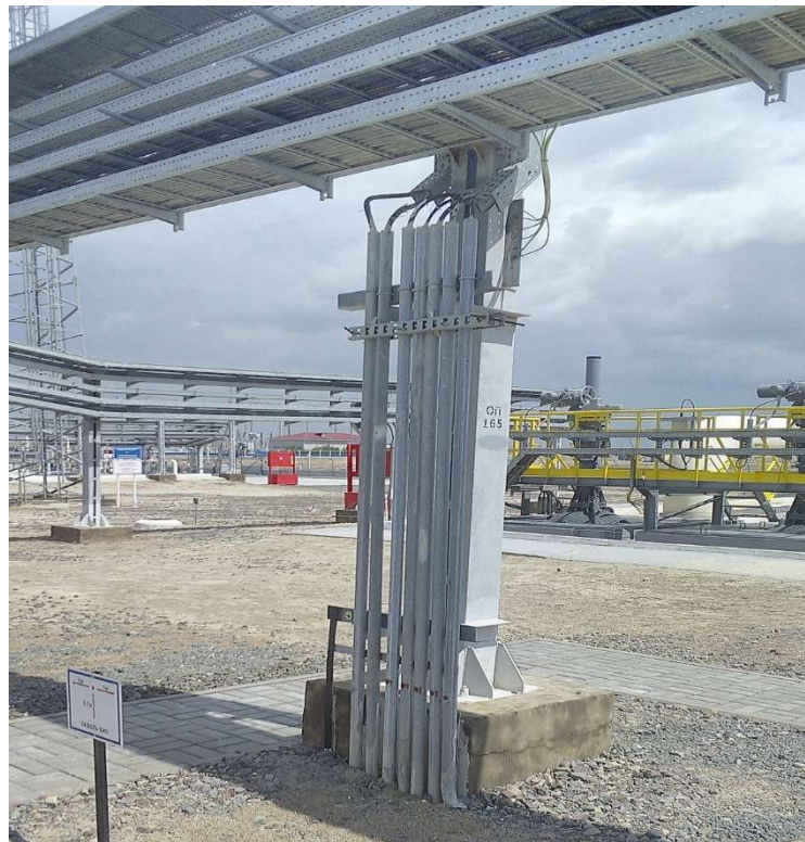
Общий вид опоры кабельной эстакады 165
