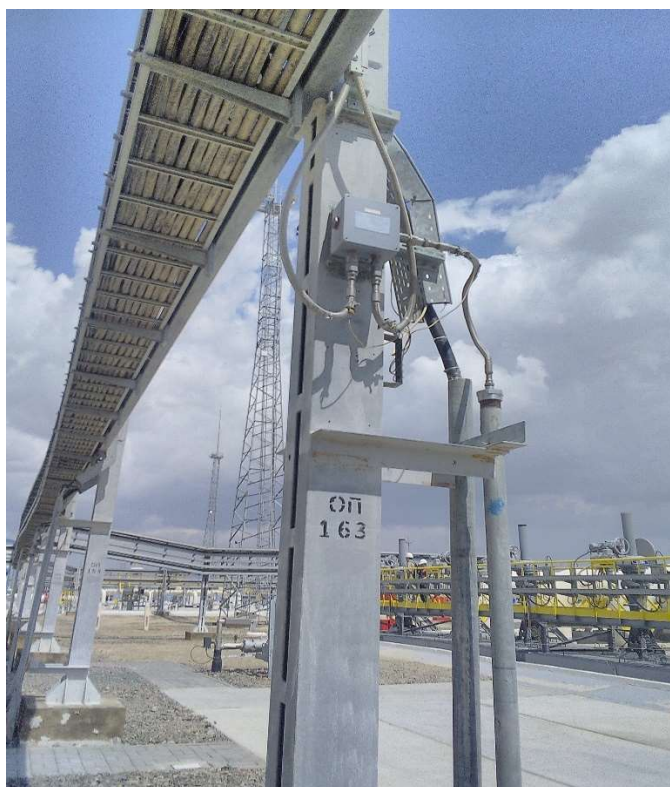
Общий вид опоры кабельной эстакады 163
