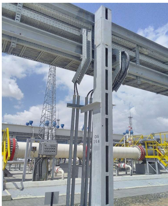
Общий вид опоры кабельной эстакады 164
