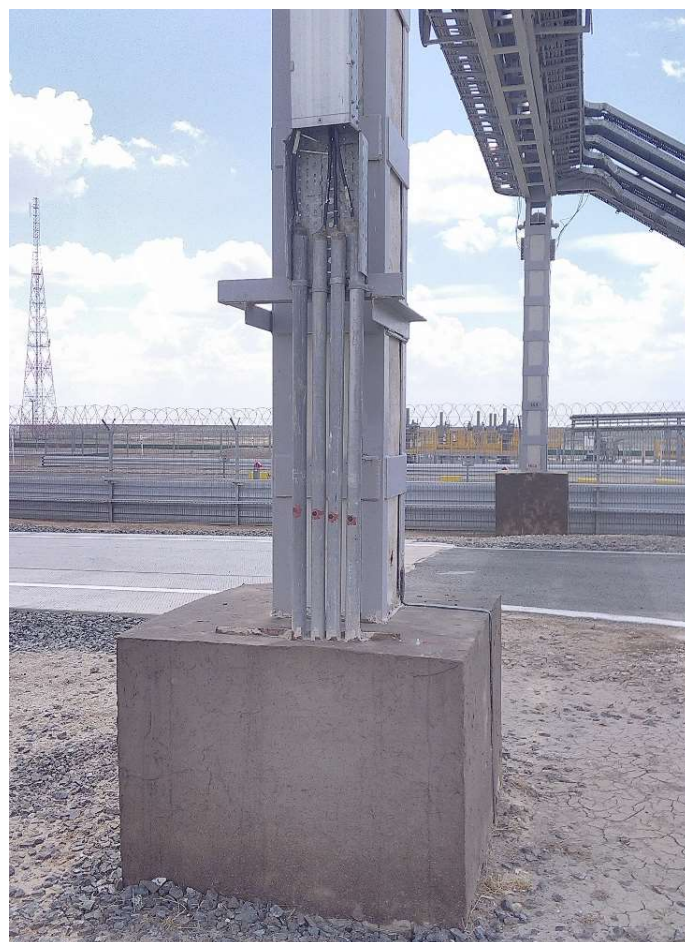
Общий вид опоры кабельной эстакады 160
