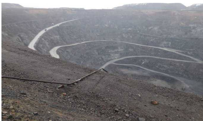
Фото 4.5 - Вид карьера (карьерные автодороги и трасса водоотлива)
