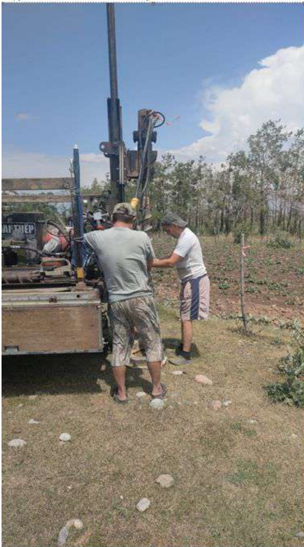
Бурение скважин на площадке строительства
