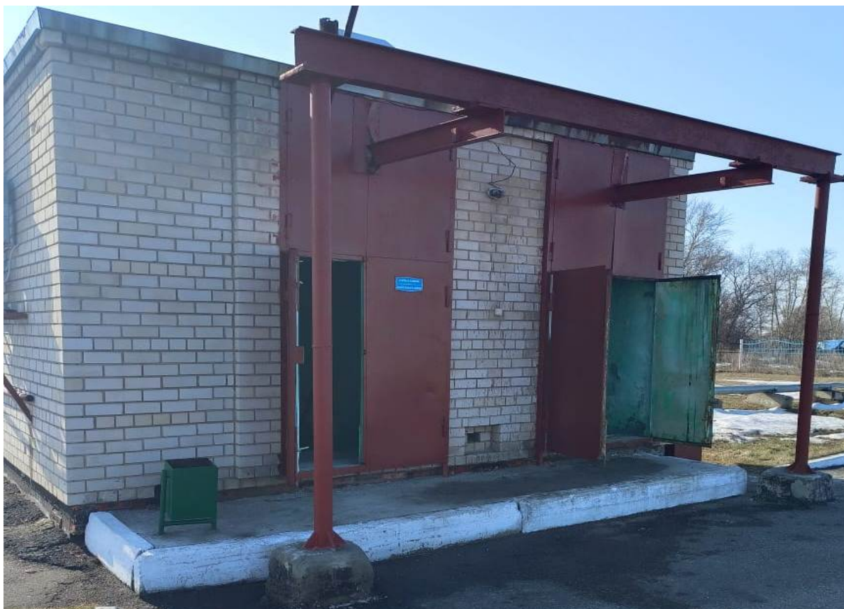
Рисунок 2.7 Здание канализационной насосной станции
