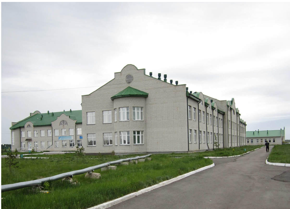
Рисунок 2.1 Здания основного корпуса
