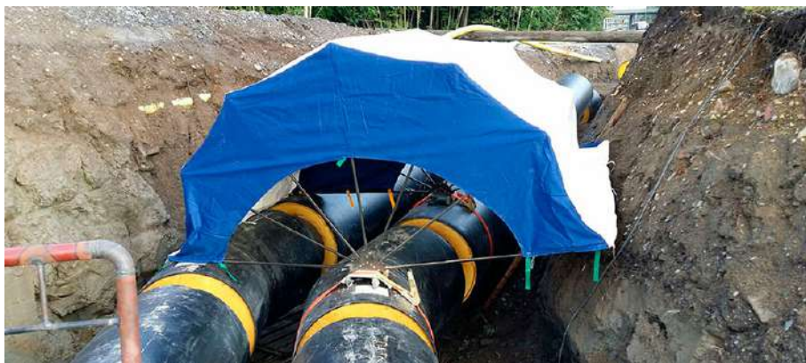
Рис.5.4.2 Палатка для защиты места сварки
