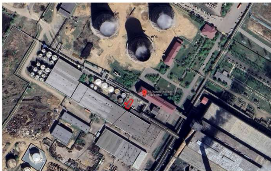
Автогараж для легковых автомашин ТЭЦ-2 по адресу: г. Астана, район Байқоңыр, Проезд 69, здание 18.
