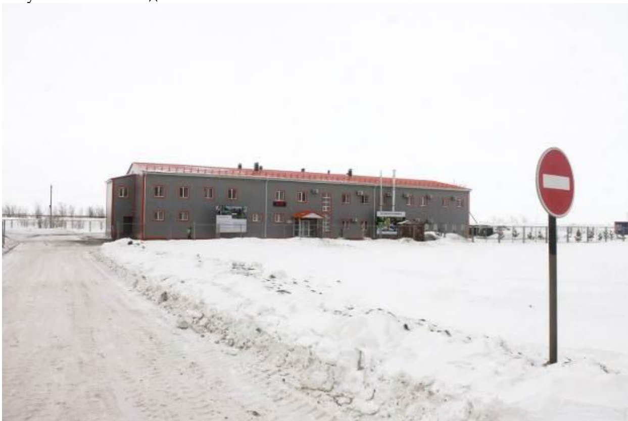
Рисунок 11 – Новое здание АБК
