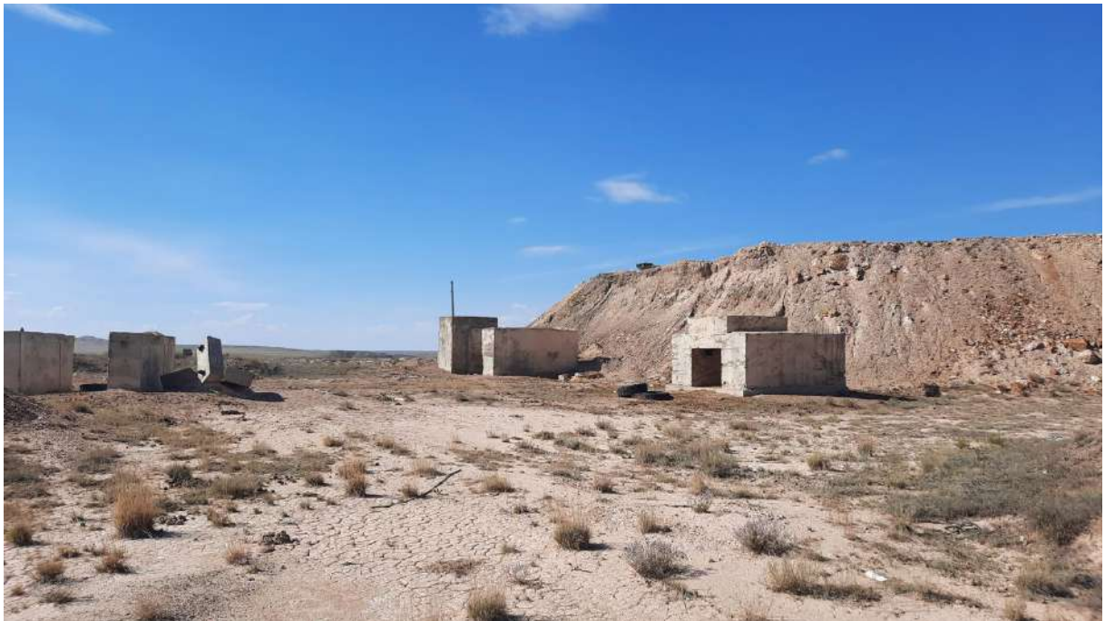
Рисунок П.1.5. - Полуразрушенные бетонные конструкции в районе расположения отвалов на месторождении
