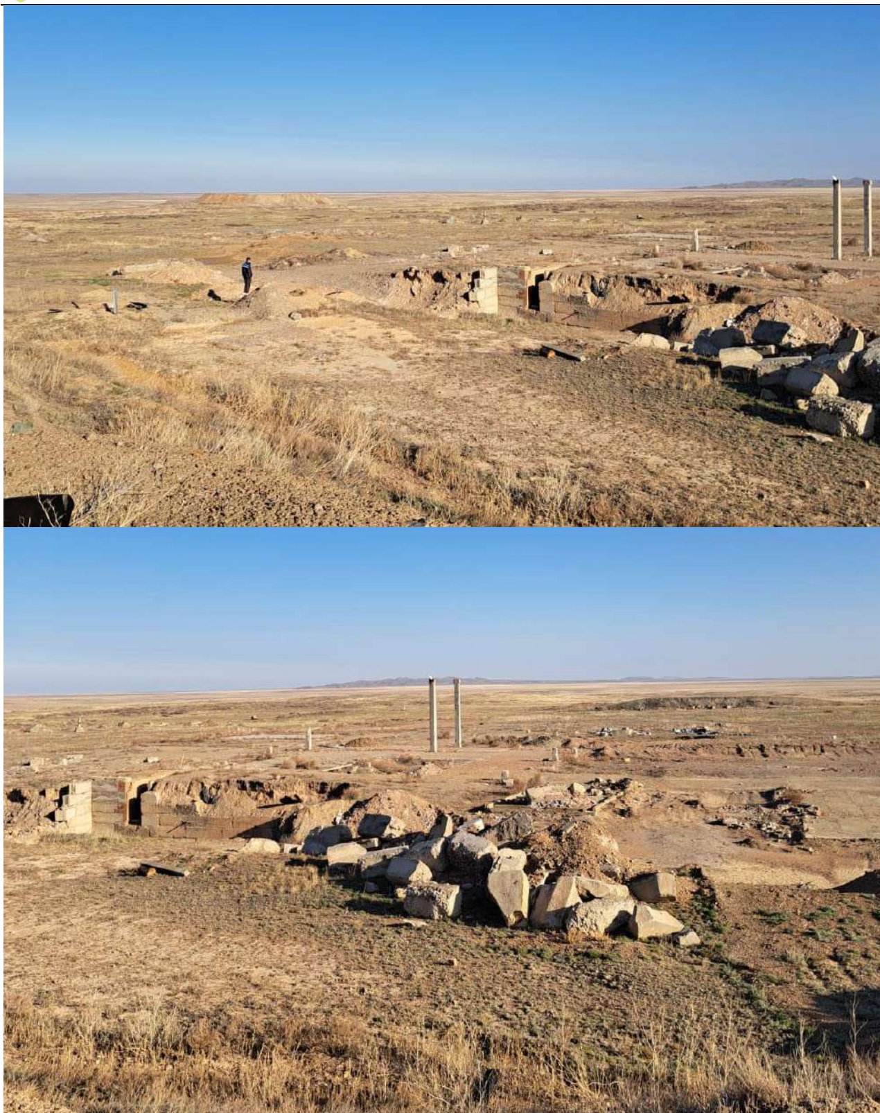
Рисунок П.1.4. - Бетонные столбы и разрушенные плиты на территории месторождения
