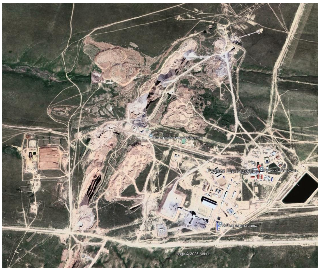
Рис. 4.3 – Текущее состояние месторождения Шатыркуль (вид сверху)
