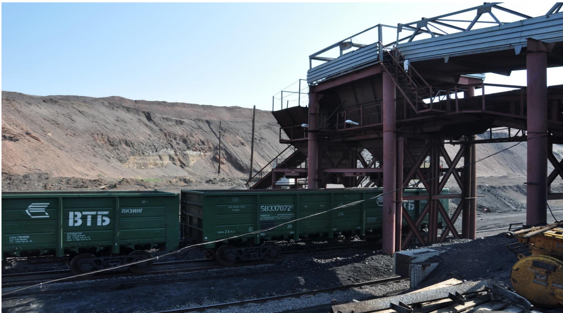
Рис. 4.4 - Угольная дробильно-сортировочная установка
