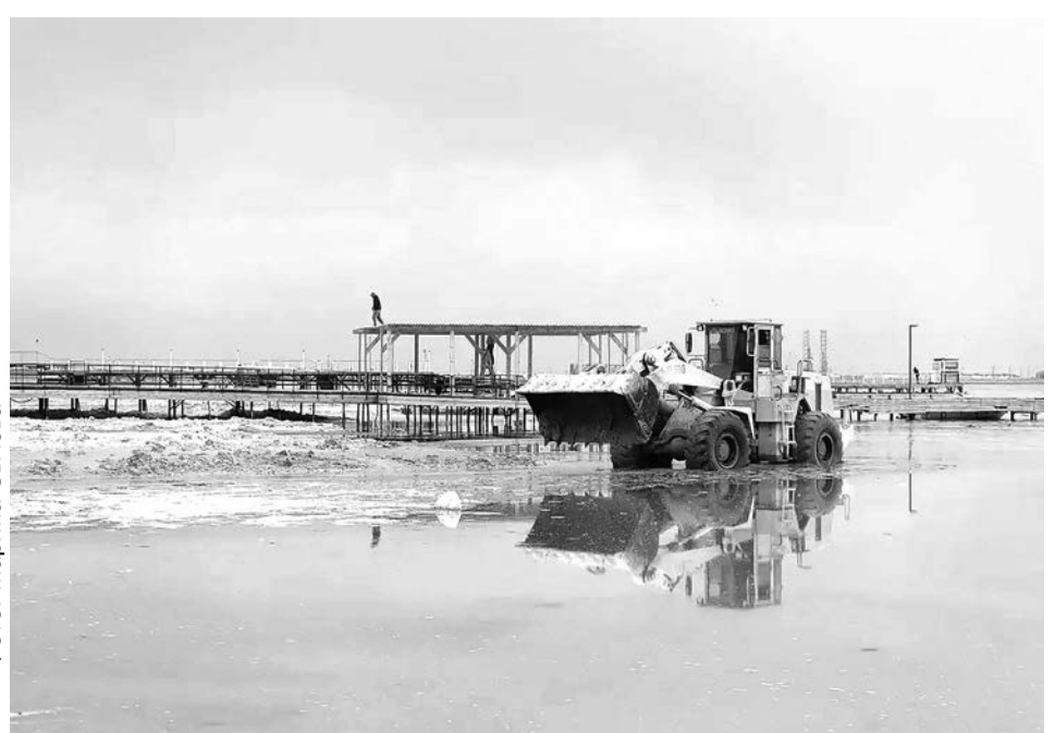
Дноуглубительные работы рядом с пирсом в Актау
