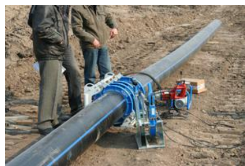
Рисунок 4.8. Стыковая сварка
