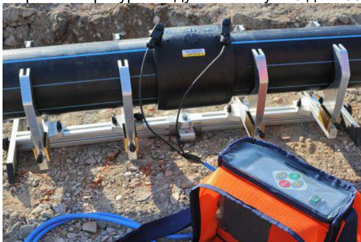
Рисунок 4.9. Сварка муфтой с ЗН
