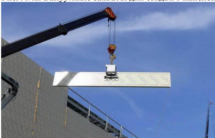
Рис. 9.7.2. Схема строповки сэндвич-панелей
