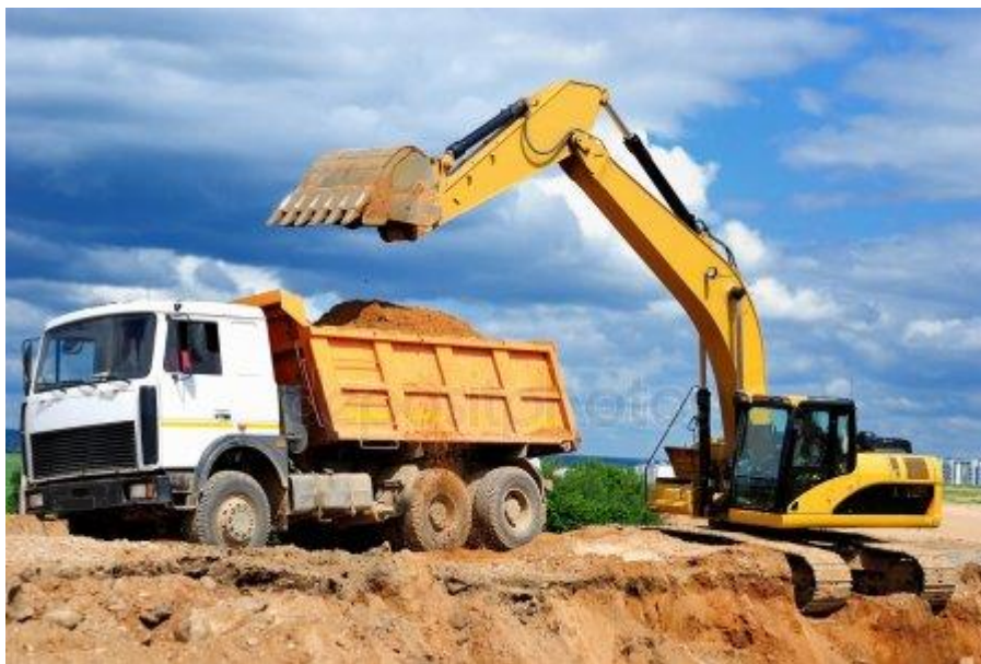
Рис 5. Погрузка ПРС
