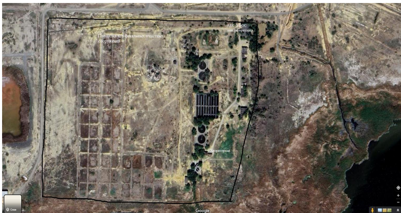
Хозяйственно-фекальные очистные сооружения (ХФОС);
