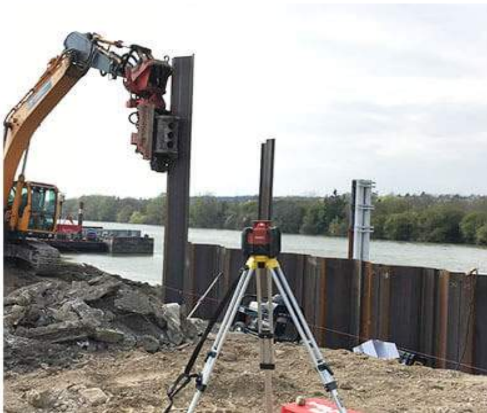
Рис.11.16. Пример устройства стальных шпунтов.
