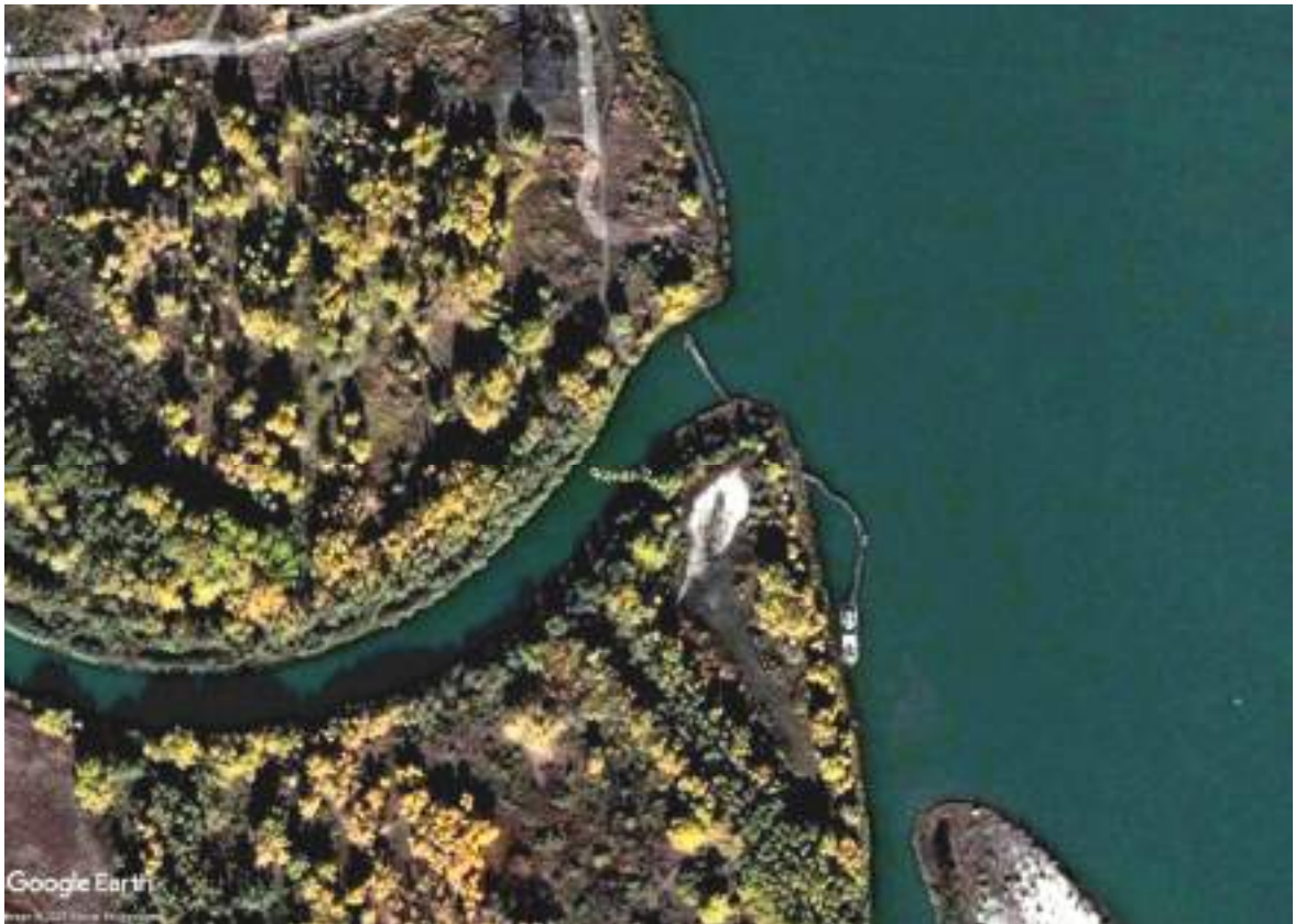
Рис.10.6. Расчистка головной части канала №2, 2005г.
