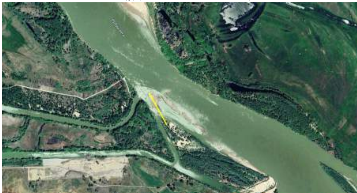
Рис.3.2. Местоположение дамбы на р.Ертис.
