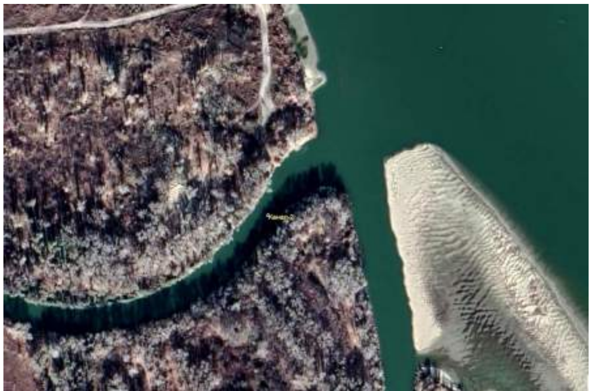
Рис.10.5. Состояние проектного участка головного участка канал №2. 2021год.
