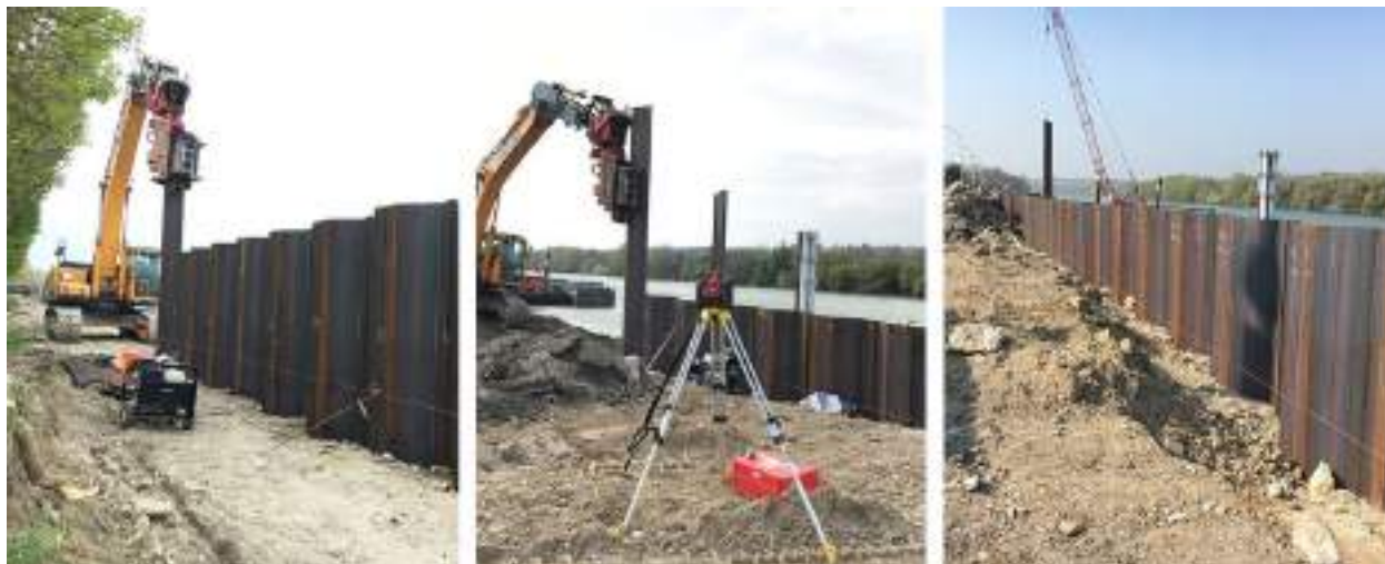
Рис.11.1 Пример проведения работ по устройству шпунтов.
