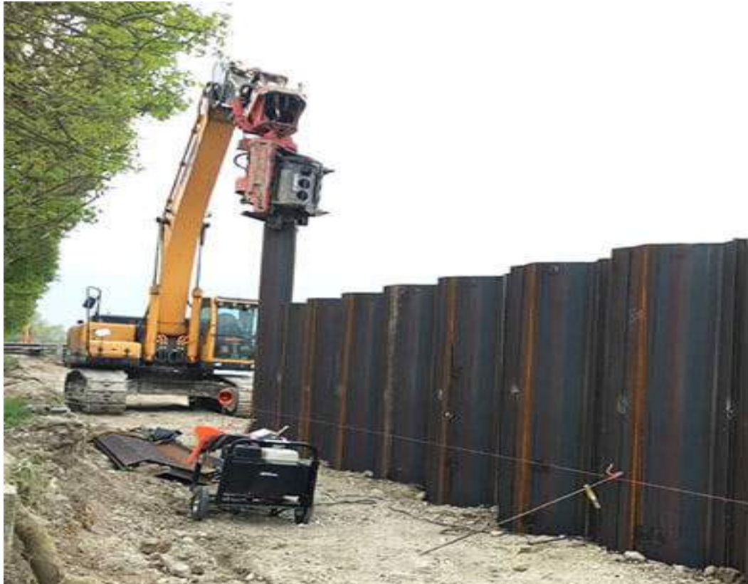
Рис.11.15. Пример устройства стальных шпунтов.
