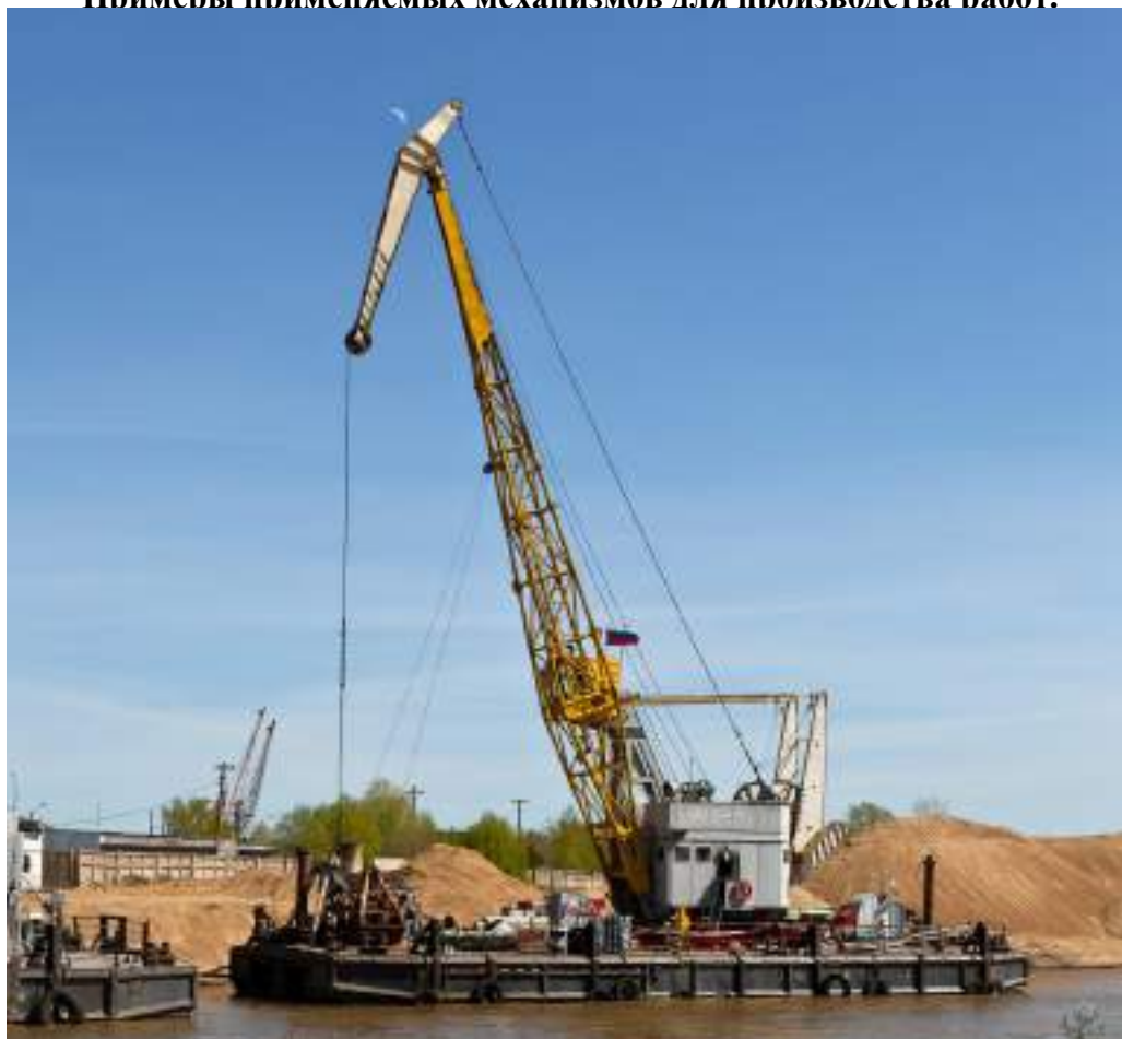
Рис.11.13. Пример погрузки грунтов с использованием КПЛ.
