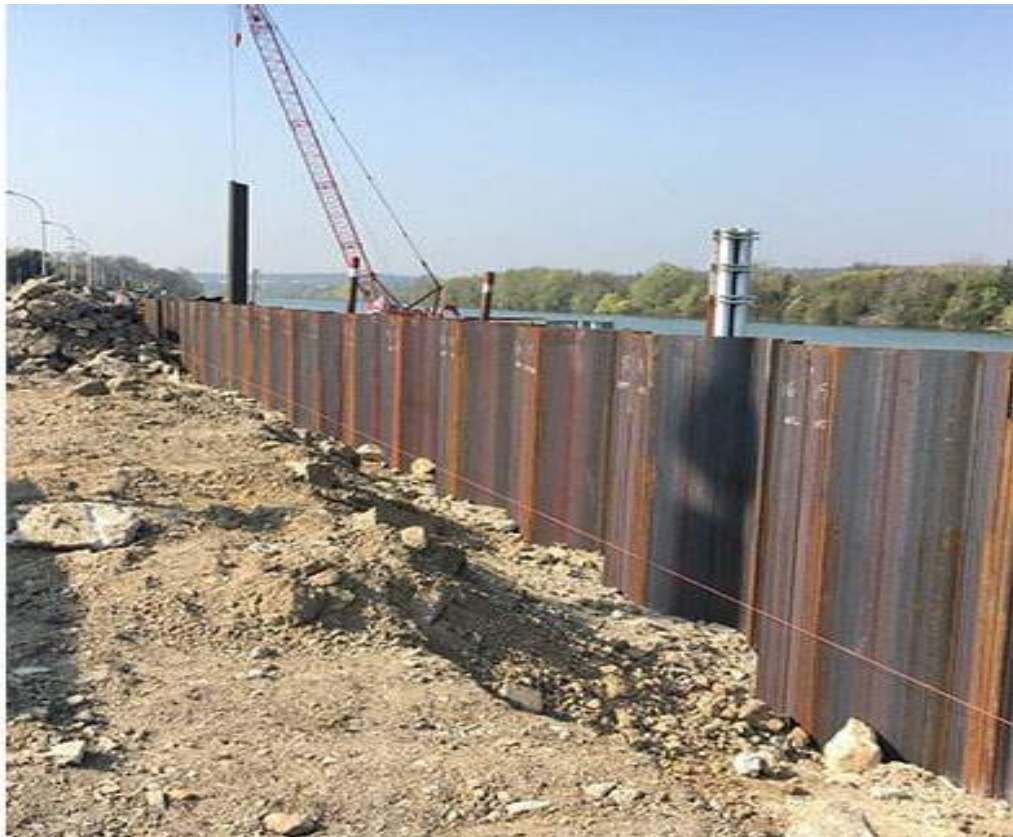
Рис.11.17. Пример устройства стальных шпунтов.
