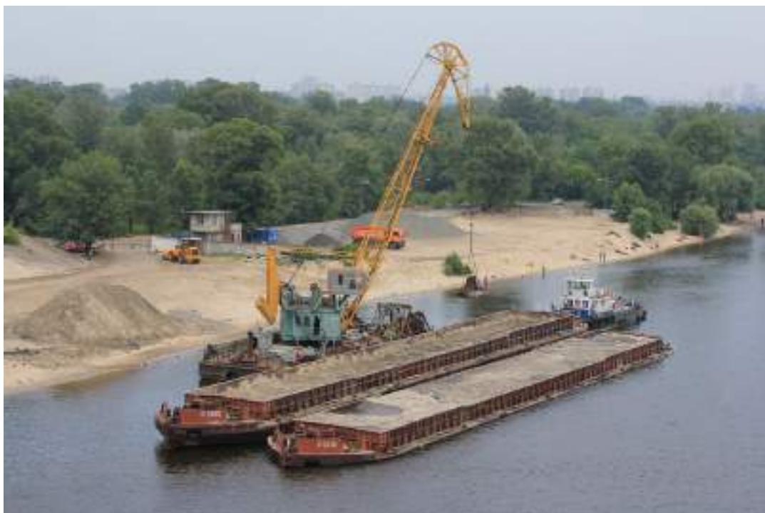
Рис.11.14. Пример погрузки грунта на баржу.
