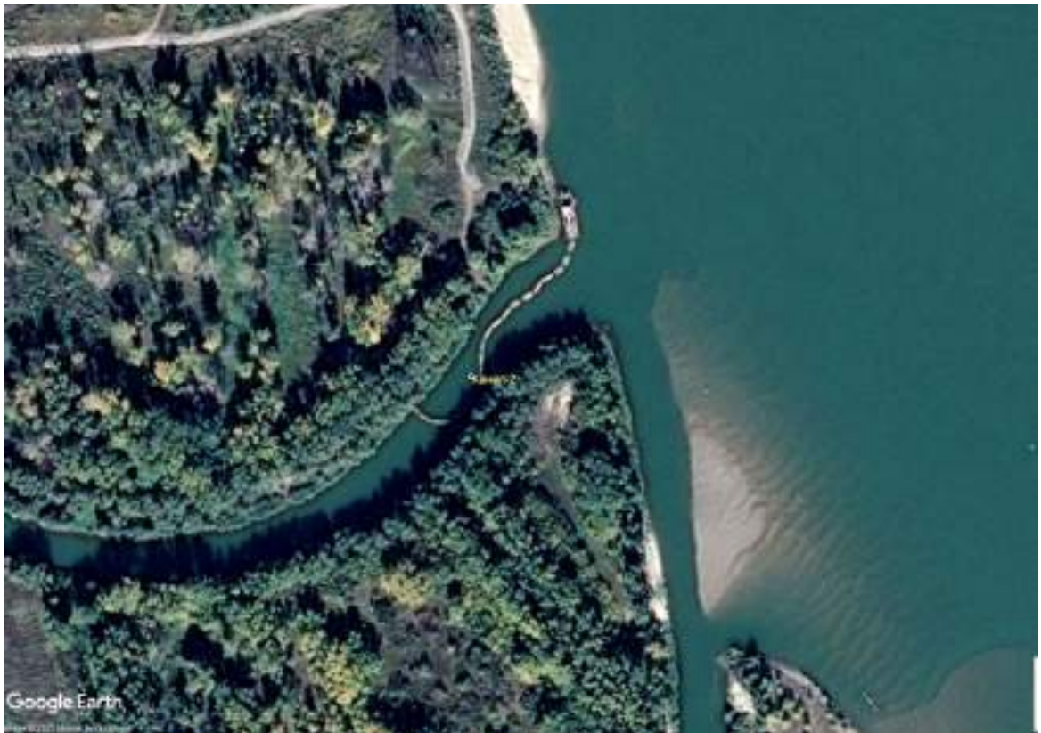
Рис.10.7. Расчистка головной части канала №2, 2020г.
