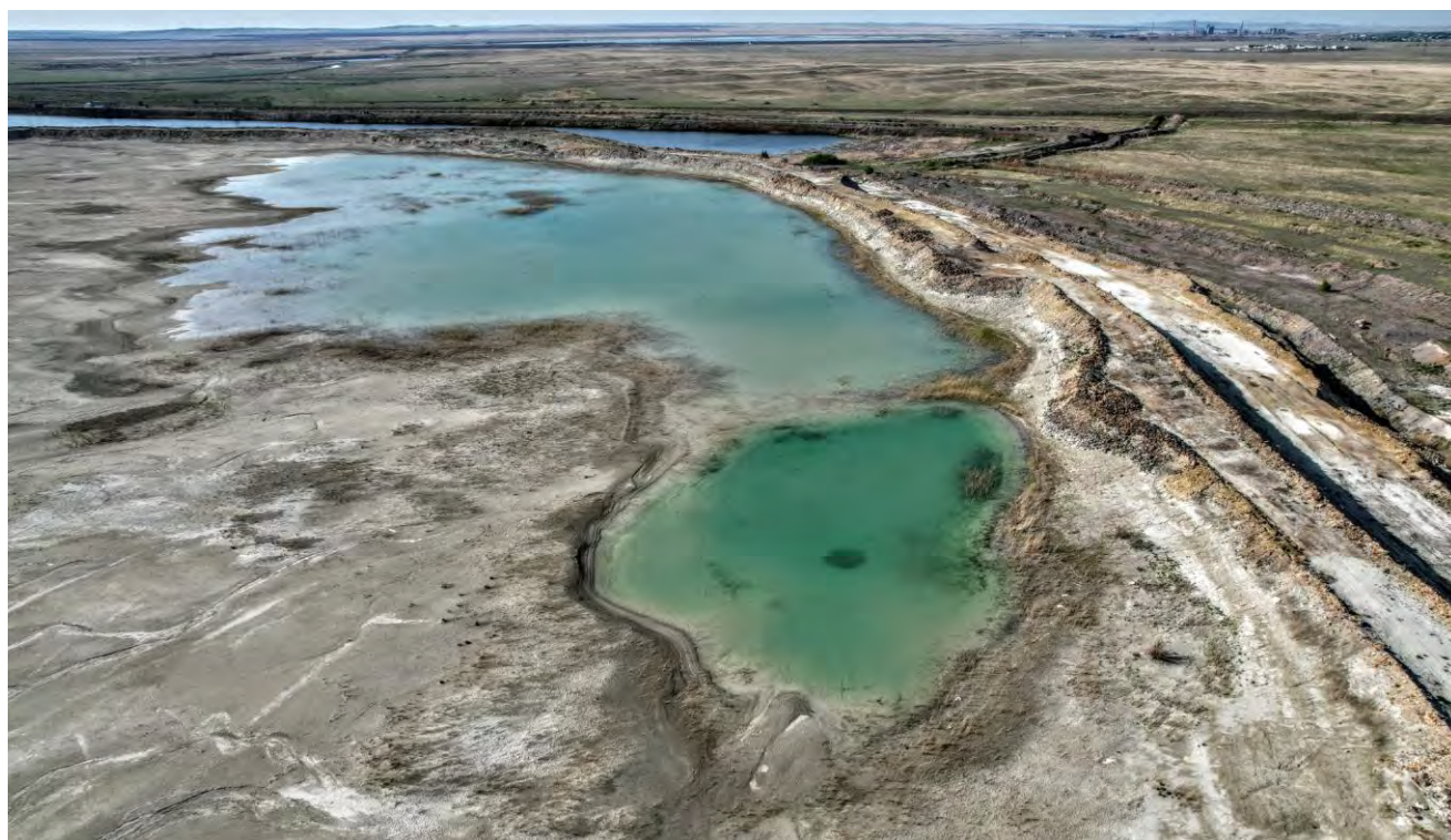
Фото 4.2.2 Скопление атмосферных осадков в центральном отсеке
