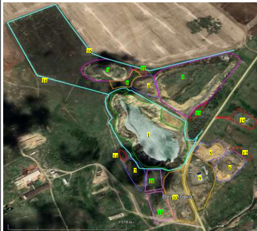
Объекты рекультивации по проекту
