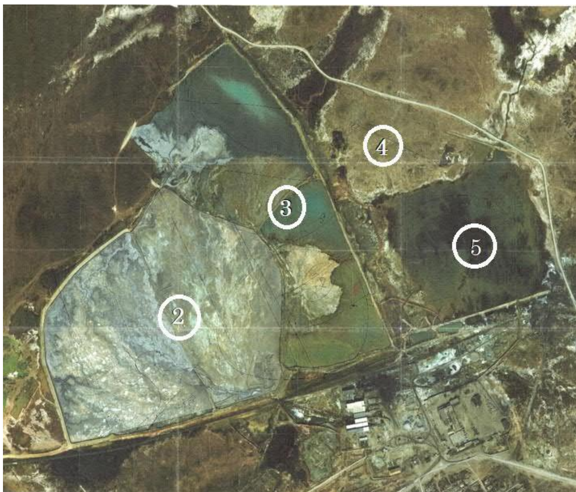
Рис.1.1 - Космоснимок Хвостохранилища № 2 Майкаинской обогатительной фабрики - Секции № 2, 3, 4, 5 (пиритохранилище)
