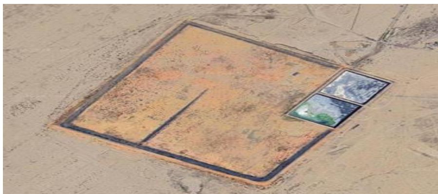
Рисунок 3.2. Пруд-накопитель хозяйственно-бытовых сточных вод
