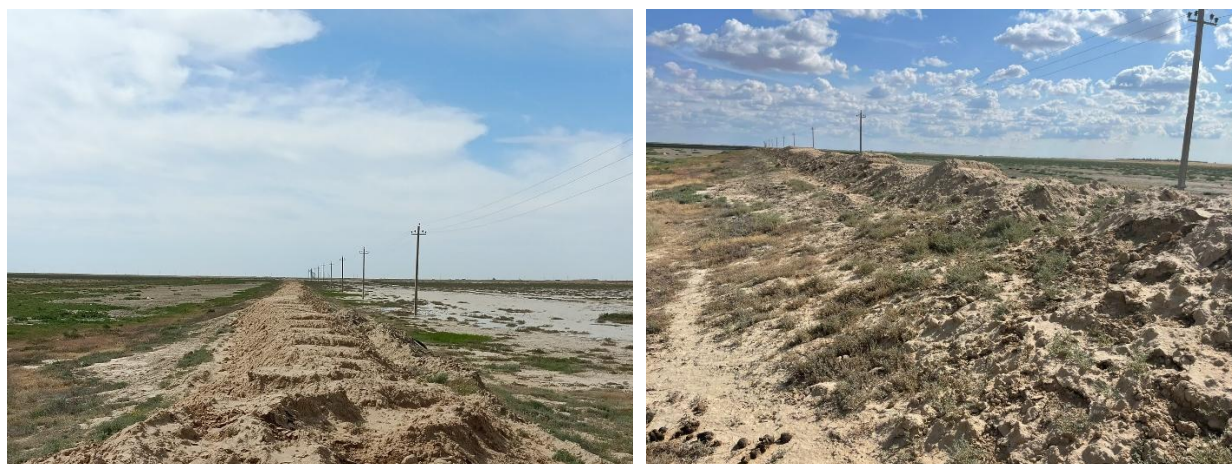
Рисунок 7.1.1. Сформированная насыпь-дамба
