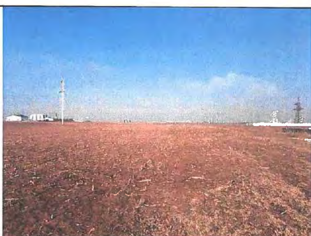
Фото 4. Объект экспертизы. Юго-восточная часть площадки. Вид на север.
