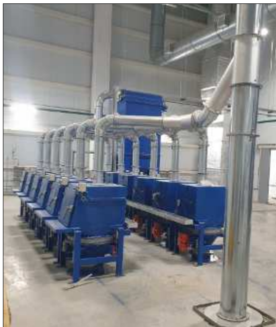
Рисунок 3.5 – Шкафы ручной загрузки МХ для линии финальных смесей (3 этаж)
