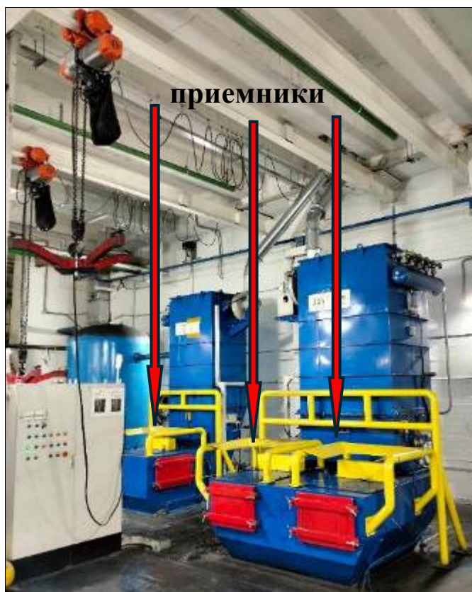
Рисунок 3.12 – Помещение растаривания (1 этаж)
