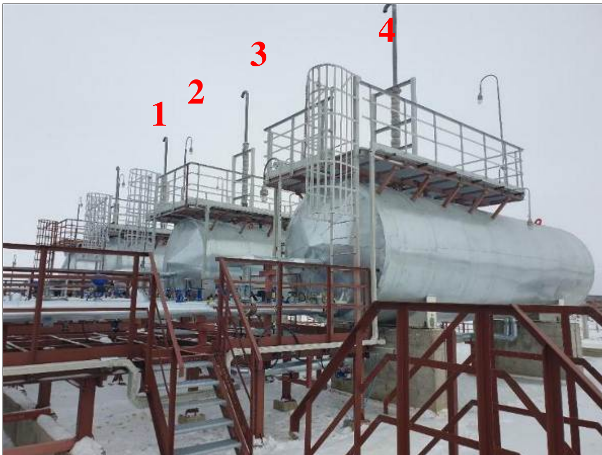
Рисунок 3.54 – Емкости с мягчителем в парке емкостей склада мягчителей
