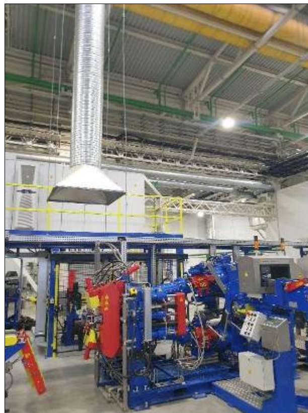
Рисунок 3.35 – Автоматизированная линия изготовления бортовых крыльев и колец для грузовых шин
