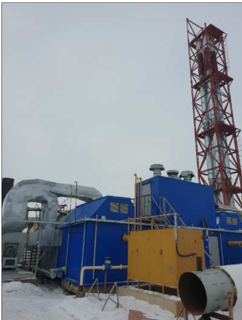
Рисунок 3.62 – Блочно–модульные котельные установки
