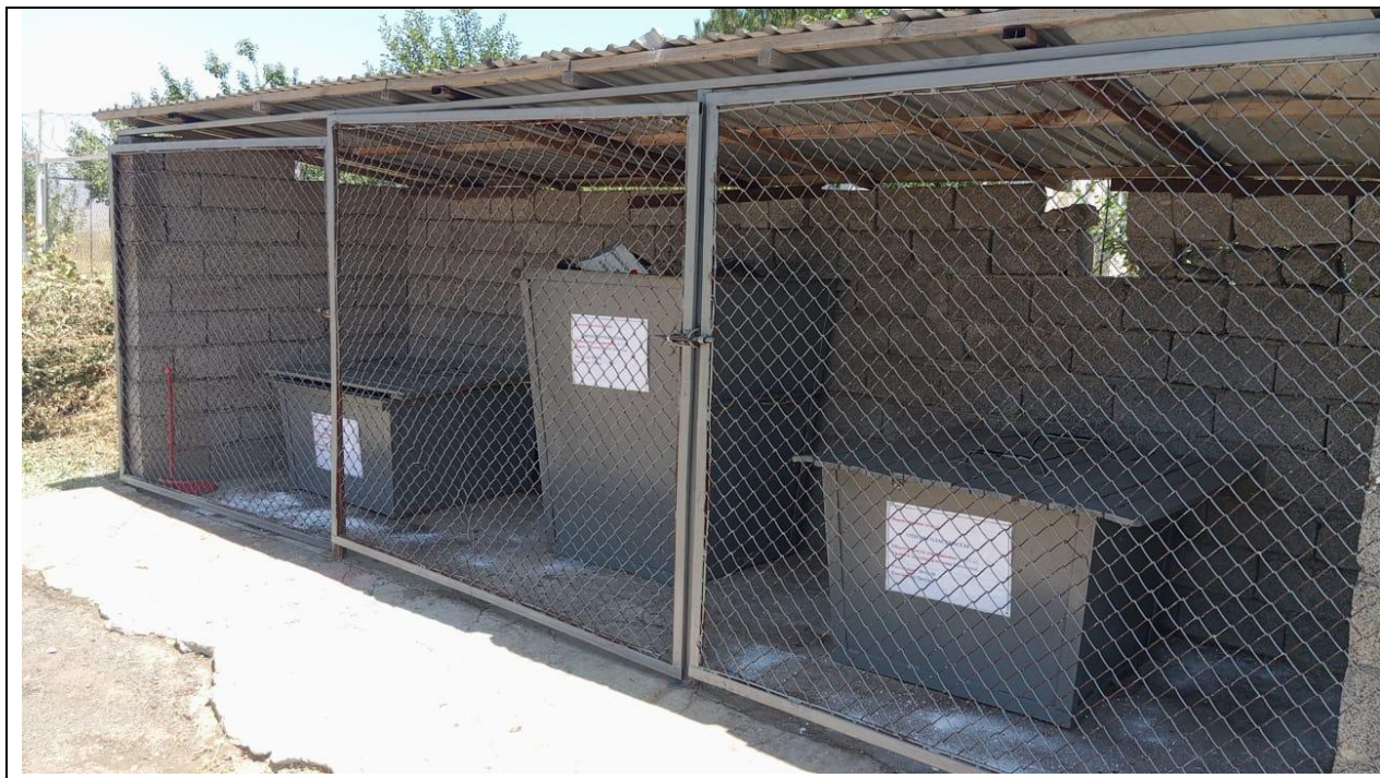
Рисунок 2.3 Фото площадок для временного накопления отходов на КС-2
