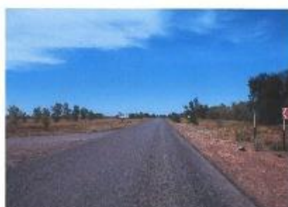
Фото 45. Обследование участка вдоль оси линии обустройства. Участок врезки в существующий надземный газопровод. Вид на север
