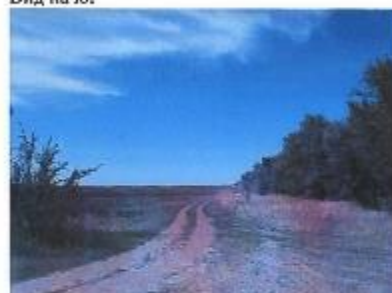
Фото 53. Обследование участка вдоль оси линии обустройства. Участок проектируемой ВЛ-10кВ от вахтового поселка до удаленного манифольда ЖКМ. Вид на север
