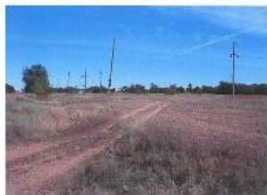
Фото 1. Обследование участка вдоль оси линии обустройства. Начало участка. Вид на север
