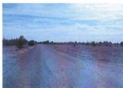
Фото 47. Обследование участка вдоль оси линии обустройства. Участок врезки в существующий надземный газопровод. Вид на юг
