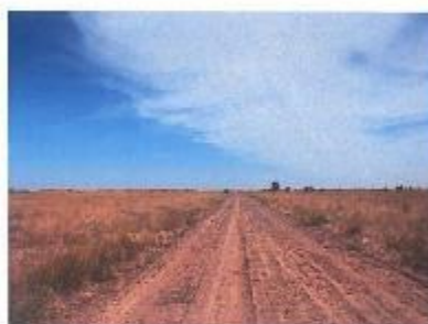
Фото 50. Обследование участка вдоль оси линии обустройства. Участок проектируемой подъездной дороги к скв. 21. Вид на восток
