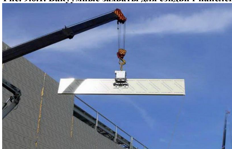
Рис. 9.6.2. Схема строповки сэндвич-панелей
