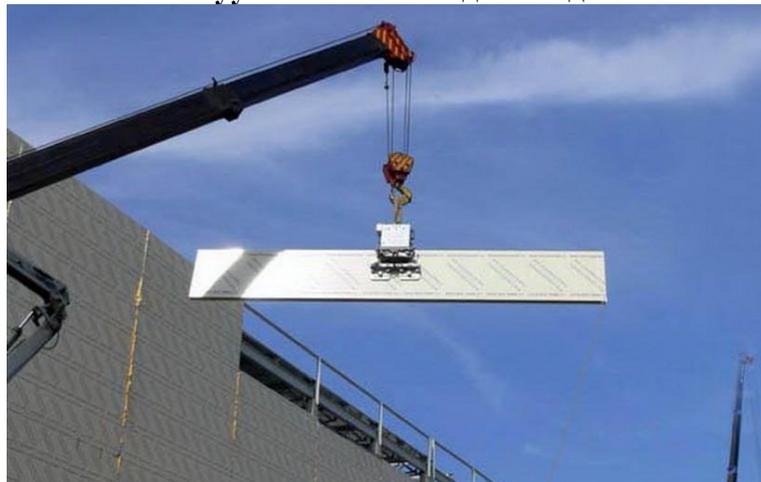
**Рис. 9.6.2. Схема строповки сэндвич-панелей**
