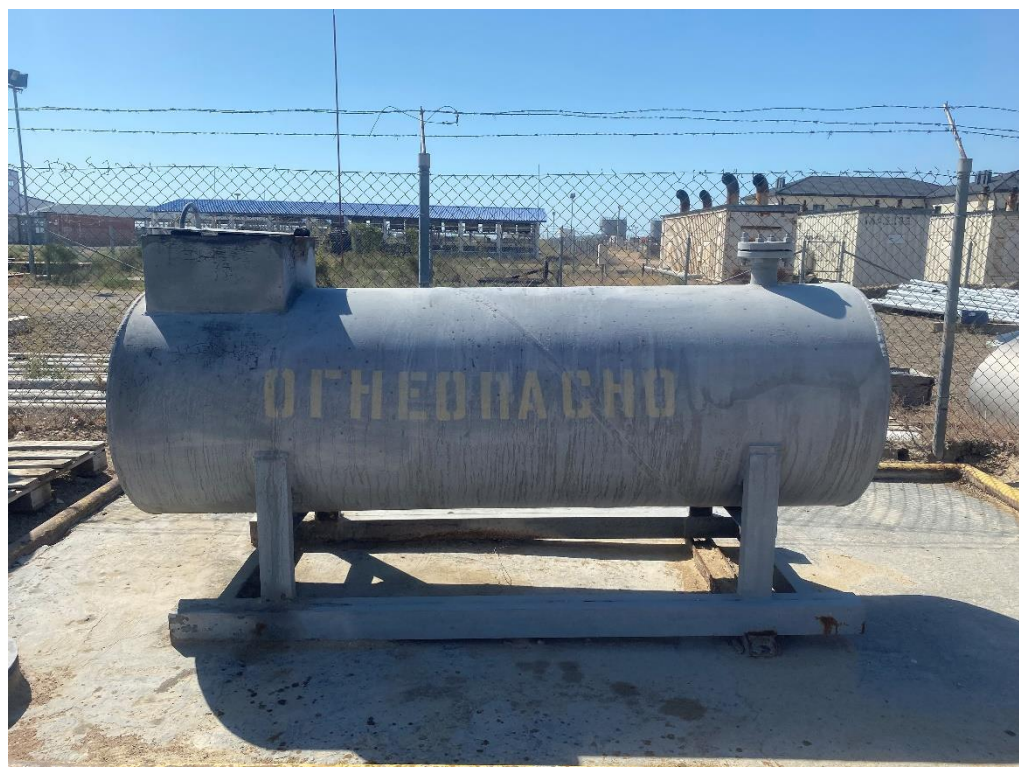
Рис 4 – емкость хранения жидких опасных отходов
