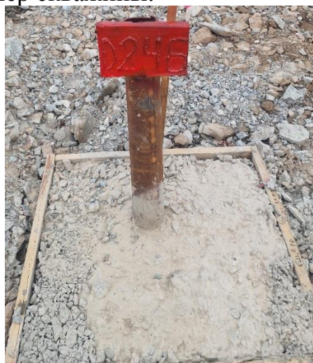
Рис.14 Устье разведочной скважины, закреплённые бетоном и трубой.
