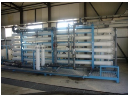
Установка обратного осмоса
