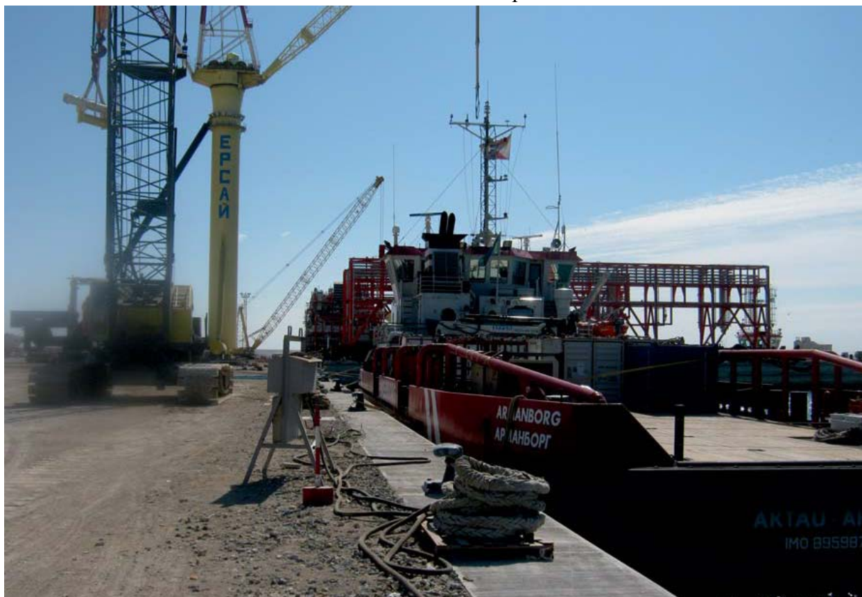
Фото 3.2. Причал. Отвод дождевых вод
