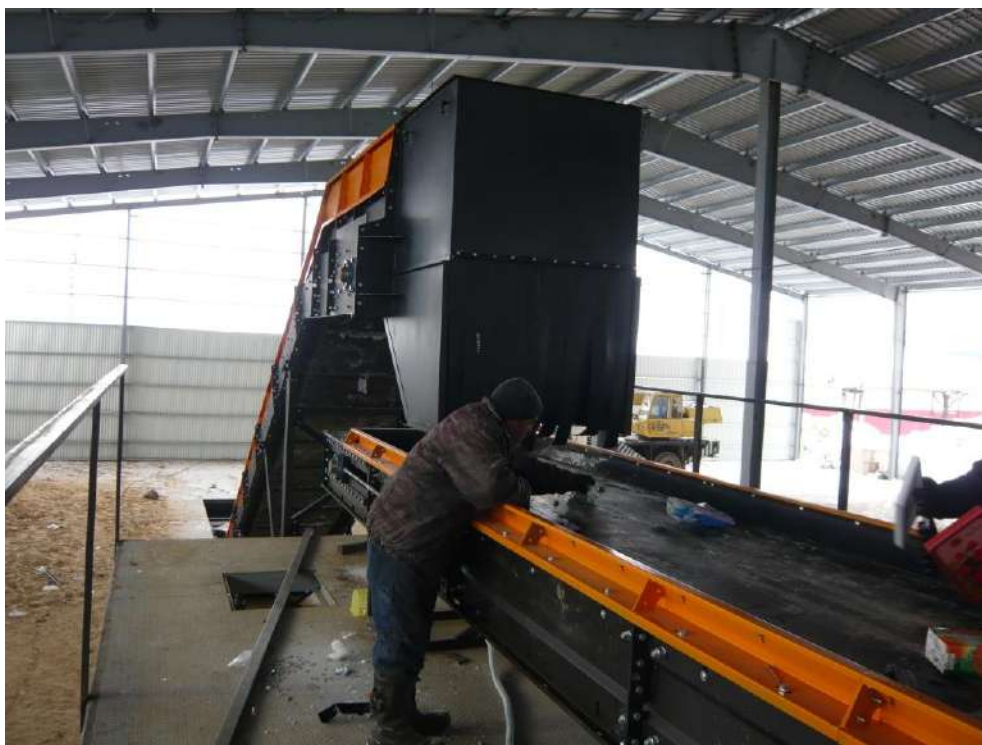
Рис. 6 . Монтаж и пусконаладка ленточного конвейера на предприятии заказчика.
