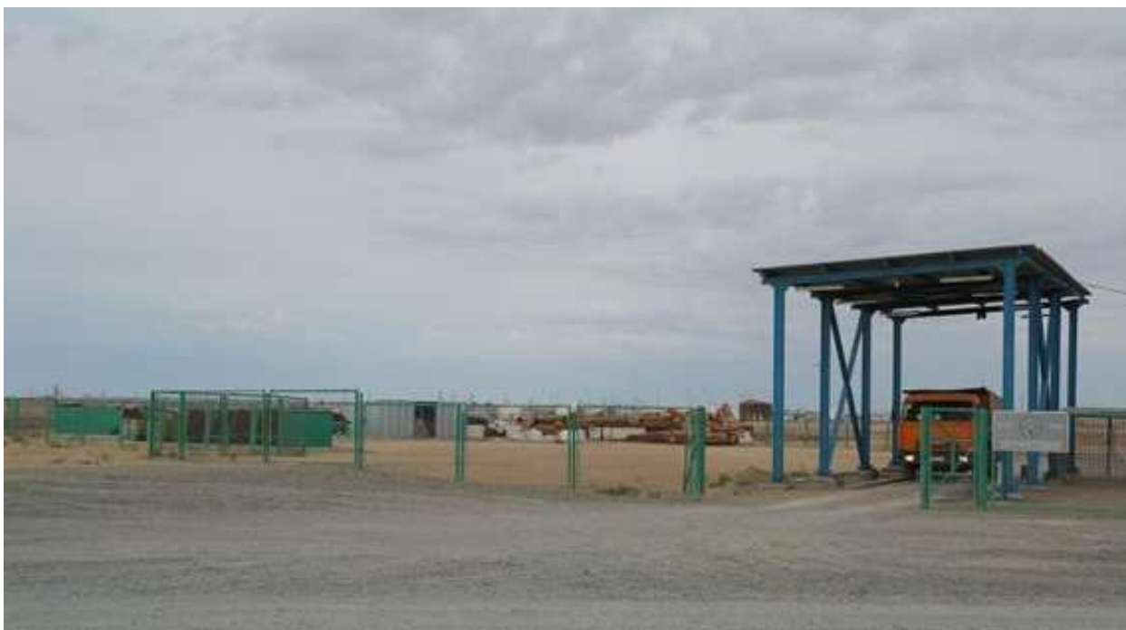
Фото 10 - Доставка отходов на площадку для сбора и временного хранения отходов на м/е «Жетыбай»
