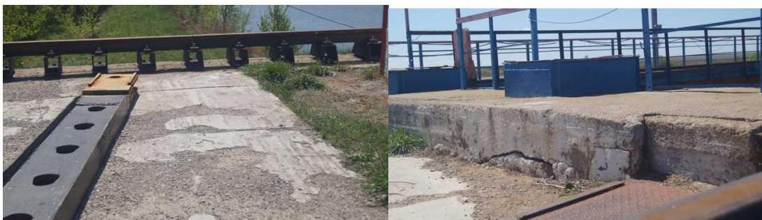
Рисунок 25 – Площадки на объекте
