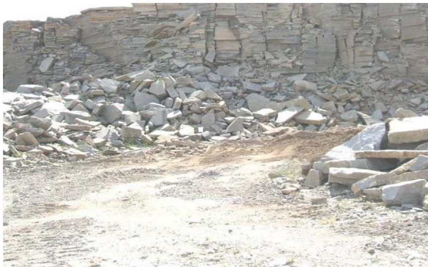
Трещиноватость и отдельность гранитов. Горизонт +295 м, северо-западный борт.
