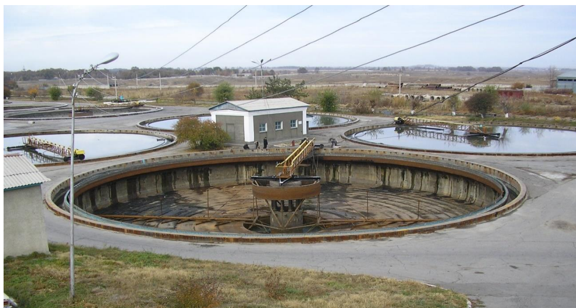
Рисунок 1.1.9 Группа первичных радиальных отстойников (в центре насосная станция)
