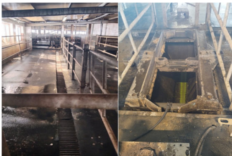
Рисунок 2 – Навоз удаляется дельта-скреперами в поперечный канал (в каждом коровнике)
