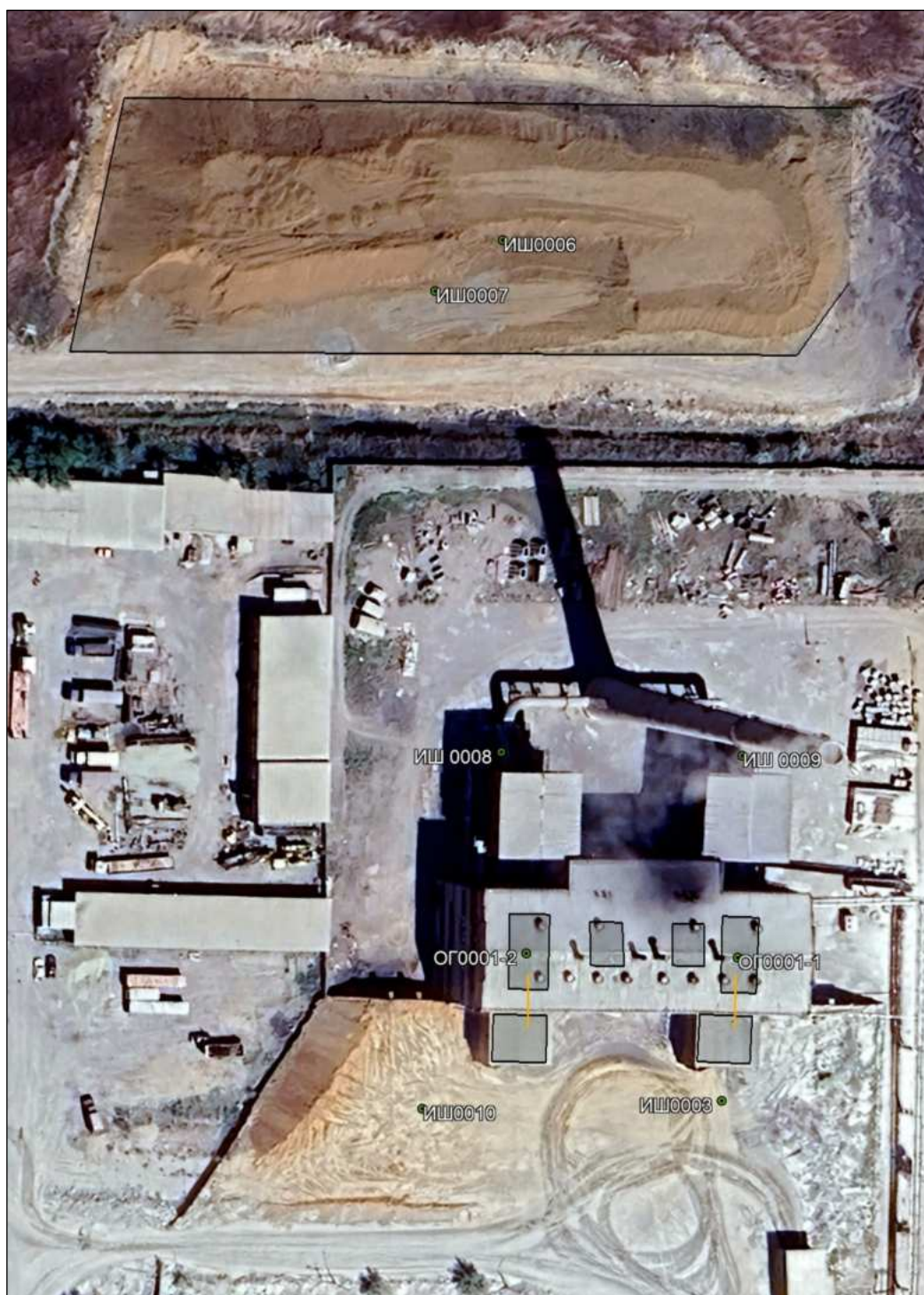
Рисунок 2.3 – Источники шумового воздействия цеха дробления и сушки суглинка. Открытые склады суглинка
