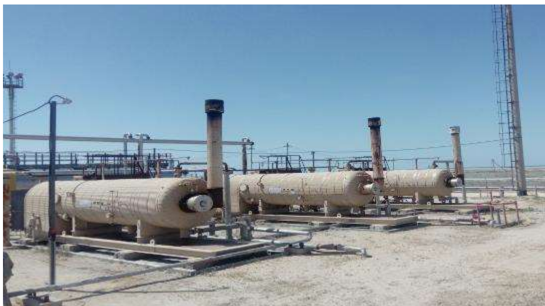
Рис. 1.2.2 Трехфазный тестовый сепаратор
