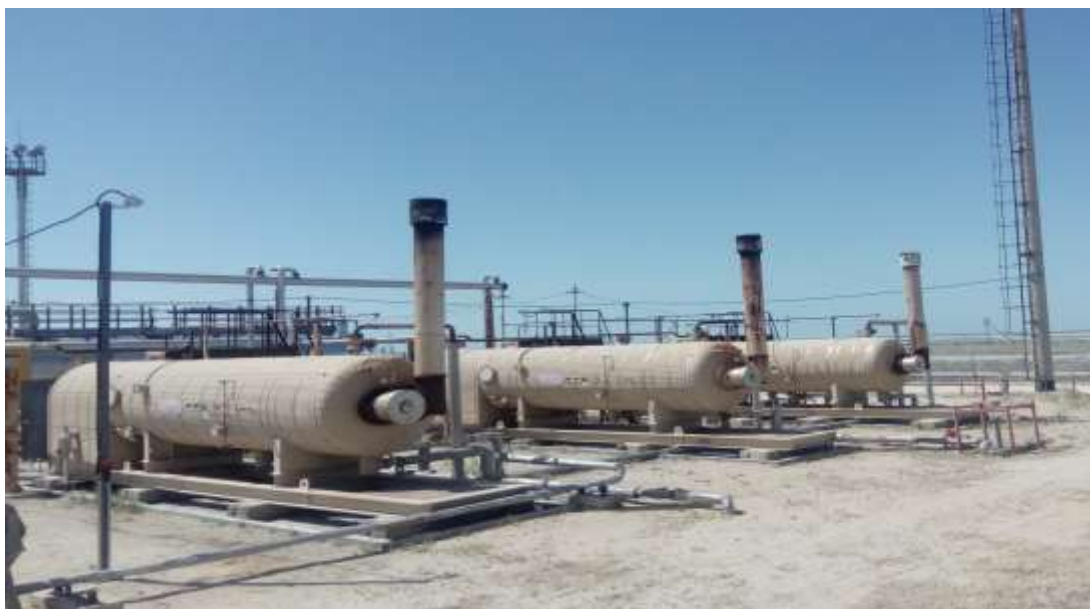
Рис. 1.1.4 Трехфазный тестовый сепаратор
